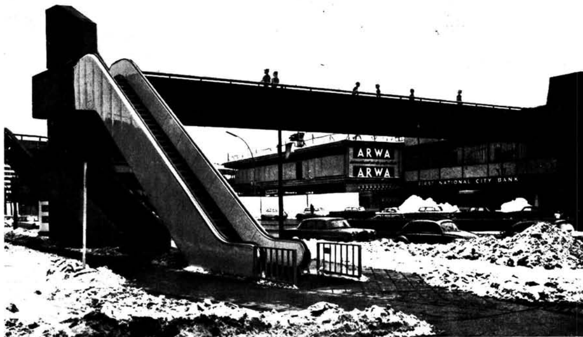
Fotgjengerovergang, Budapester strasse, Berlin
