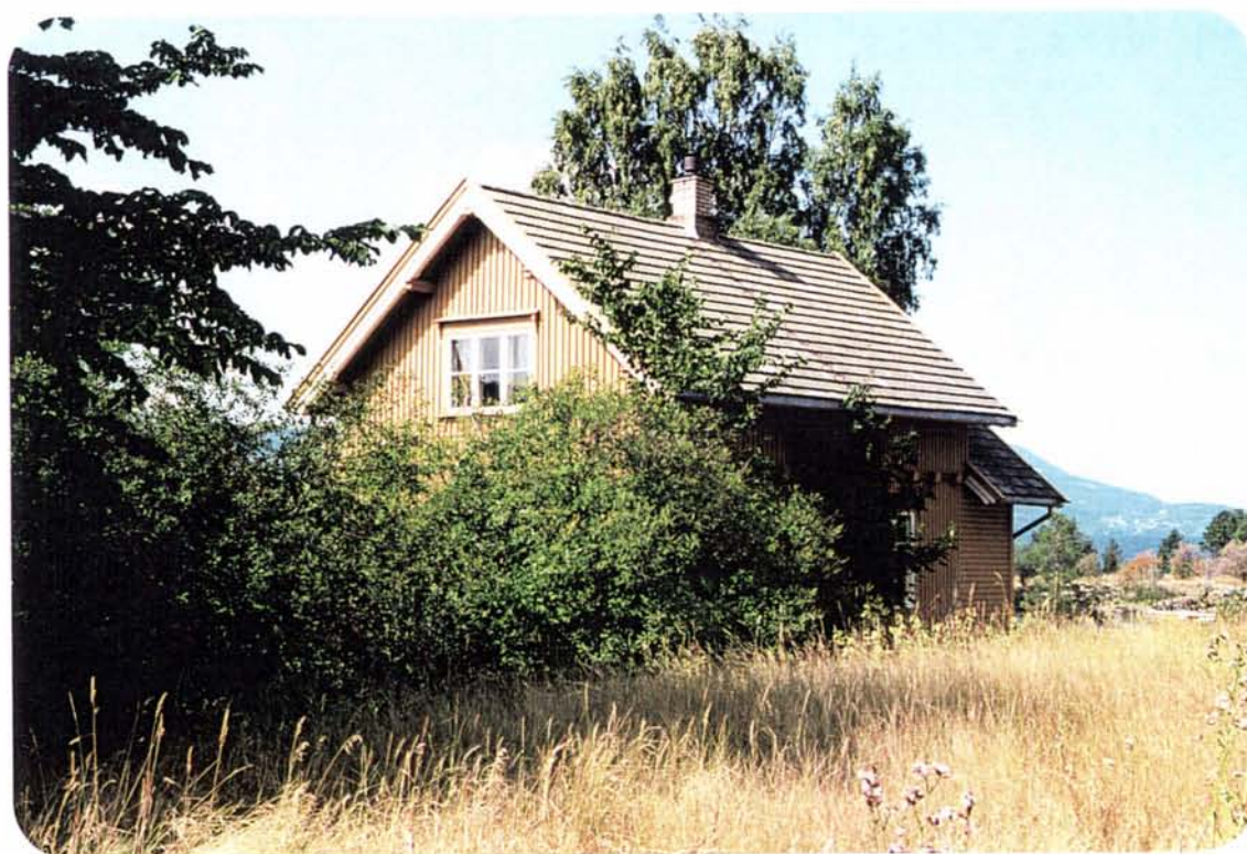
Foto 11: Vokterboligen ved Morskogen av type "Normal Z", oppført i 1877, står fortsatt i god tilstand omgitt av frodig plantet vegetasjon. Typen fins ennå i NSB's eie på ialt 7 steder langs Hedemarksbanen.
