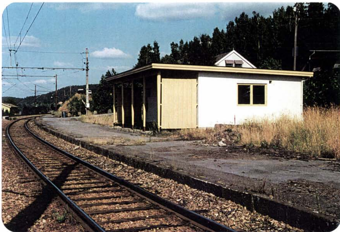
Foto 14: Stasjonsbygningen ved Espa fra 1964 kan vel knapt karakteriseres som noen arkitektonisk perle. Den er snarere et uttrykk for en tidsepokes rasjonelle arkitektursyn, og har som sådan sin egenverdi.
