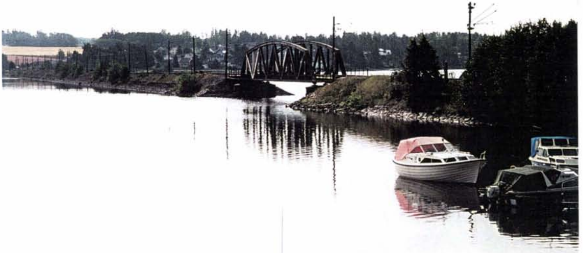
Foto 26: Et av de største negative inngrepene i landskapet i forbindelse med dette baneanlegget er utvilsomt den snorrette fyllingen over Åkersvika, som avsnørte vika fra resten av Mjøsa. Bildet er tatt mot fagverksbrua som ble bygget over åpningen gjennom fyllingen. Idag er fyllingen tilgrodd og inngrepet noe dempet.
