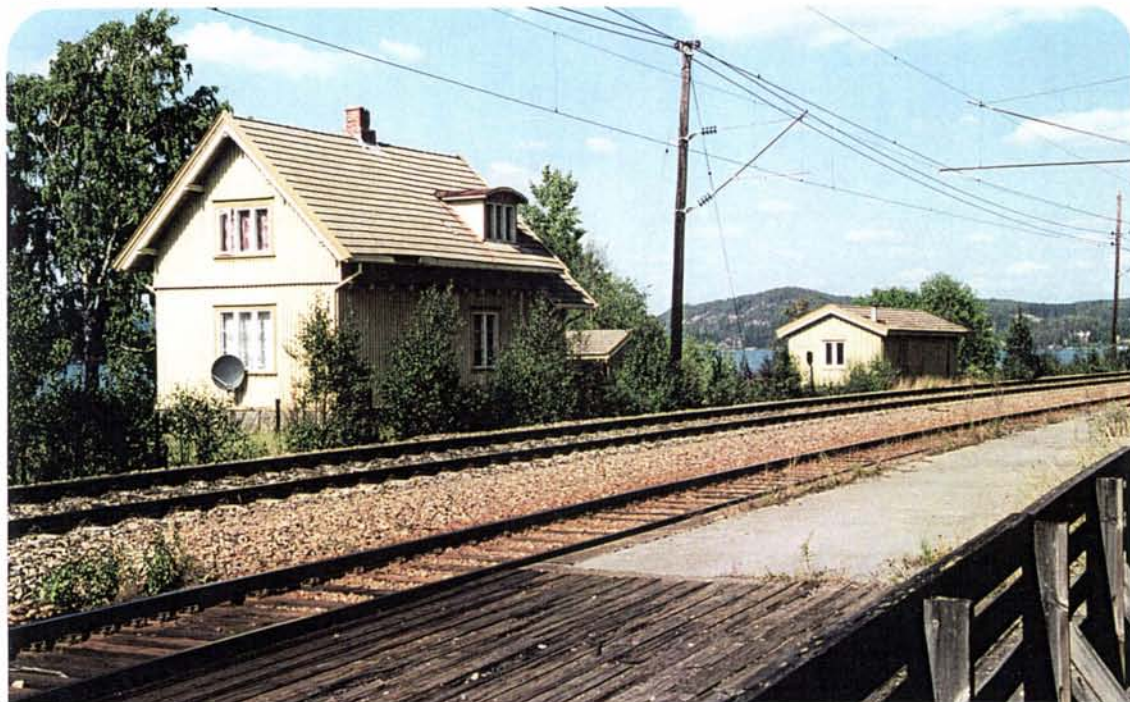
Foto 15: Vis a vis stasjonsbygningen ved Espa ligger tre bygninger som oppleves som et enhetlig NSB-bygningsmiljø. Vokterboligen er her som ved Morskogen av type "Normal Z". De andre husene på fotoet er uthus og en bygning for baneavdelingen.
