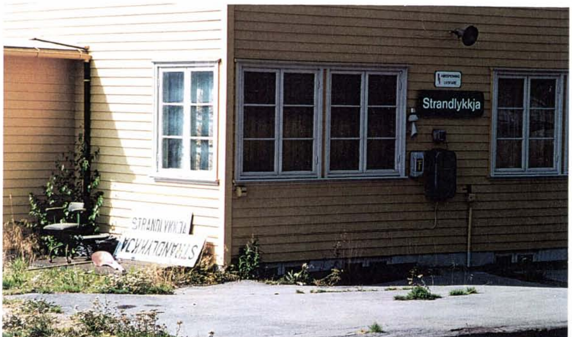
Foto 13: Stasjonsbygningen ved Strandlykkja har også vært offer for NSB's noe overivrige hang til å gjennomføre designprogrammet fullt ut. Nye stasjonsnavnsskilt passer ikke uten videre på eldre bygninger. De pensjonerte skiltene sees til venstre.
