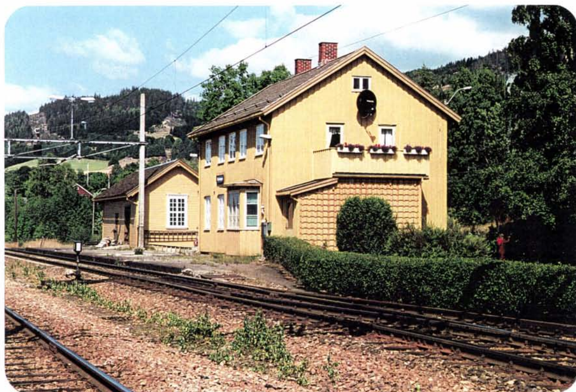
Foto 10: Morskogen stasjon ligger som en liten idyll nede ved Mjøsa. Stasjonsbygningen er sterkt ombygd, mens godshuset er i sitt opprinnelige formspråk. Merk den fine hagen i forgrunnen.
