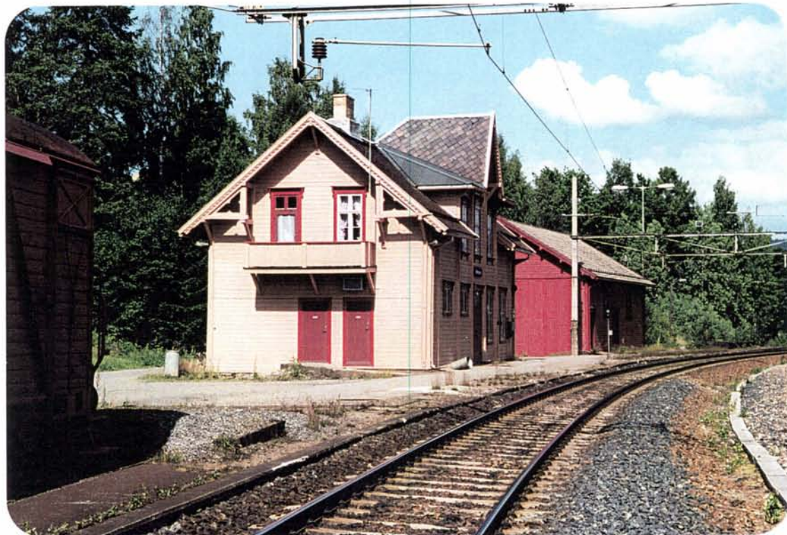
Foto 4: Minnesund stasjon (arkitekt Balthazar Lange, 1879) med sin tidstypiske stasjonsbygning i sveitserstil. Den karakteristiske arken er bygd på noen år senere (ark. Paul A. Due). Ellers er stasjonen lite ombygd, og er idag den best bevarte av de opprinnelige stasjonsbygningene som ble oppført langs Hedemarksbanen.
