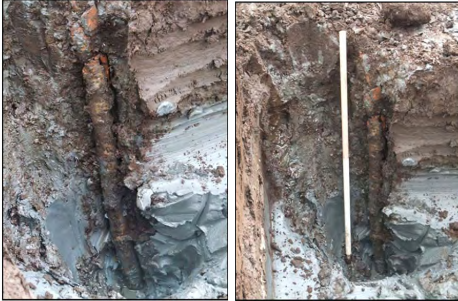
Bilde 77: Til venstre: Påle i kvikkleire nært myra. Til høyre: Samme påle med stikkstang på 1m. Foto: Magnus Helstad.
