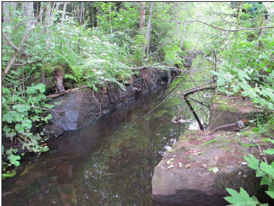
Bilde 120: Brofundament nord for Steinsrud stasjon. Foto: Magnus Helstad.
