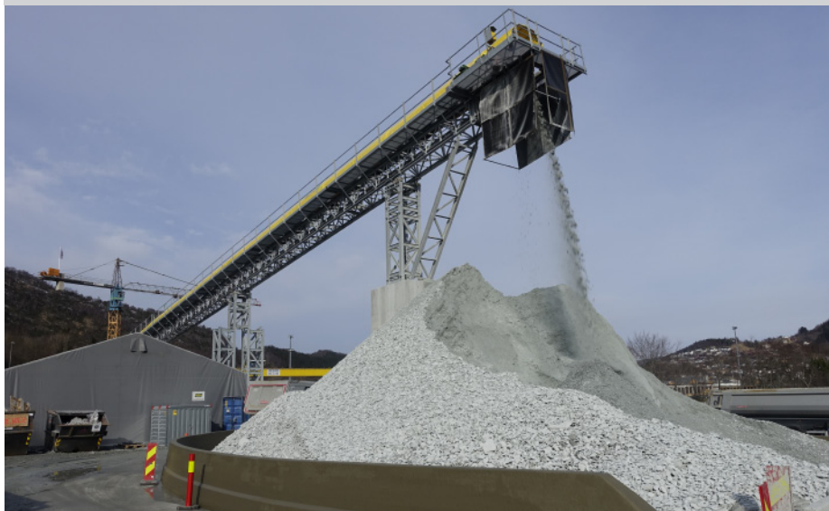
Steinmassene fra tunnelboremaskinen fraktes ut på et transportbånd og hentes av lastebiler utenfor tunnelen.
