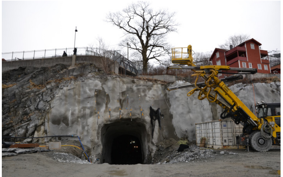
Anleggstunnelen under Fløen og Årstad skal være ferdig til sommeren.
