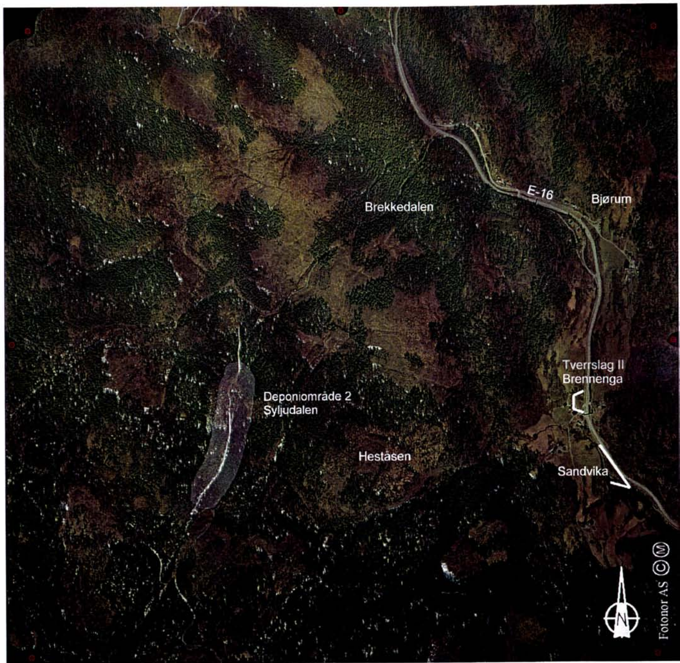
Flyfotoet viser deponiområdet i Syljudalen for tverrslag II ved Brennenga
