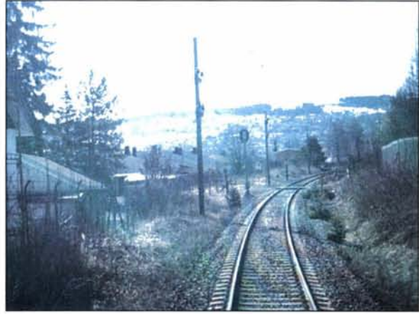
Figur 3: Viken planovergang sett i retning fra Gjøvik stasjon. (Foto: Jernbaneverket)
