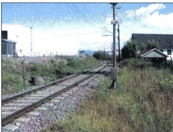
Figur 4: Sikt fra nedsiden av planovergangen, mot Gjøvik.
