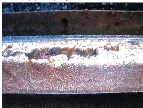
Figur 5: Avskalling på kjørebanelen.
