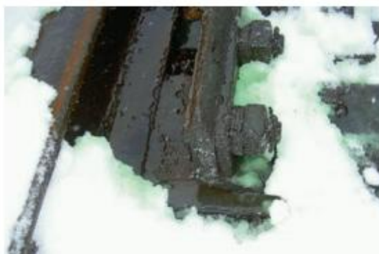
Figur 3-18 Avising/deising av sporveksel med Midwest kjemikalie. [59]
