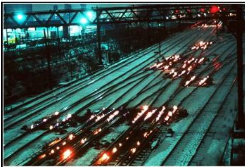
Figur 3-17 Sporvekselvarmere drevet av gass[58]
