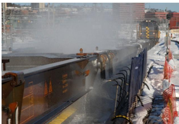
Figur 3-5 Avisingsanlegget på Alnabru sprøyter en godsvogn [27]
