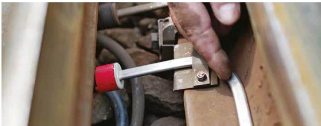
Figur 3-14 Komponenter i sporvekselvarme monteres på skinnen [8]
