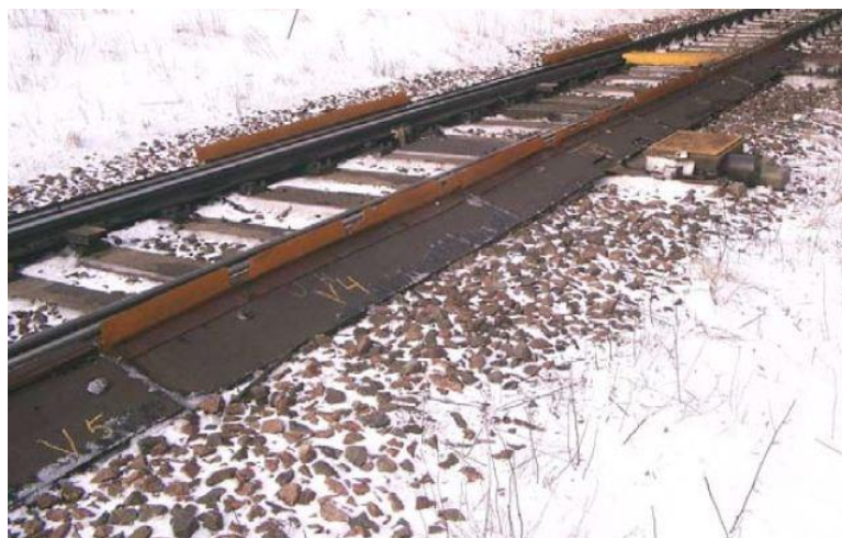
Figur 3-20 Gummispoiler og dekker langs sporet og isolerende deksler [6]
