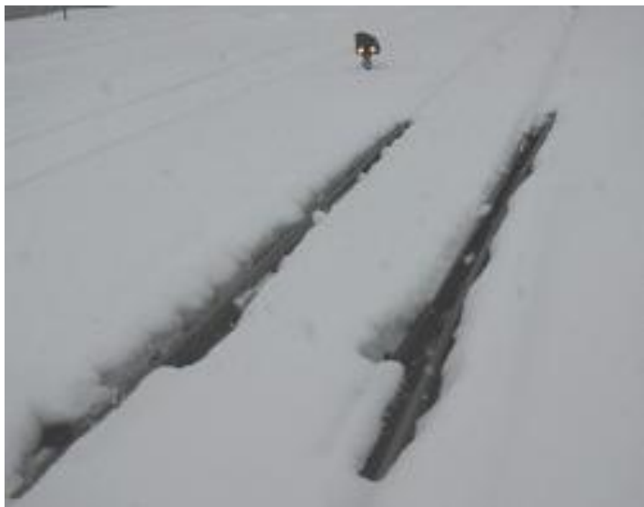
Figur 3-13 Smelting med sporvekselvarmer [35]
