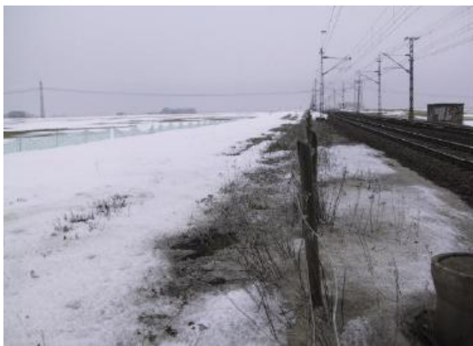
Figur 3-1 Snøskjerm på Skåne på Södra Stamban [12 s.15]
