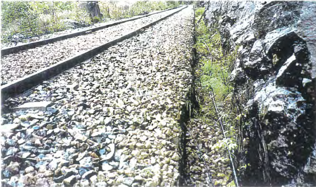
FIGUR 2-11 Fjellskjæring med kantstein på strekningen 139,3-140,9
