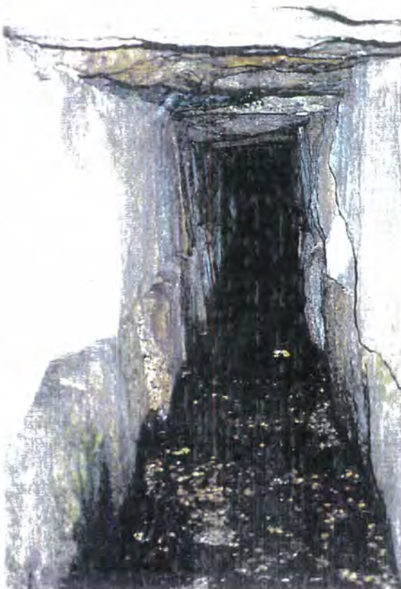
FIGUR 2-9 Steinrenne med bra tilstand ved km 152,635
