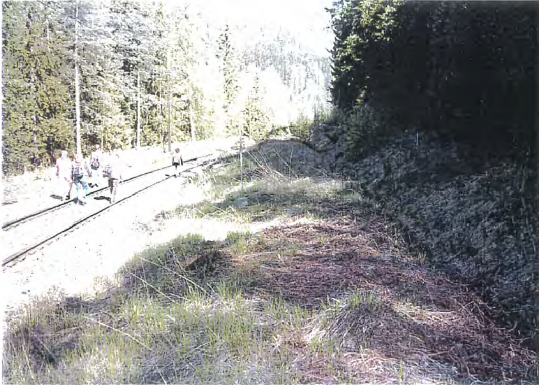
FIGUR 2-15 Terrenggrøft med bra standard ved km 194
