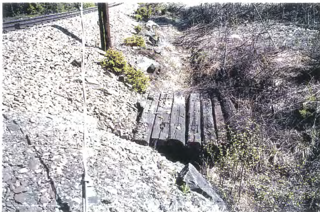
FIGUR 2-14 Stikkrennas innløp er tildekket med svilleoverbygg. Km 195,4
