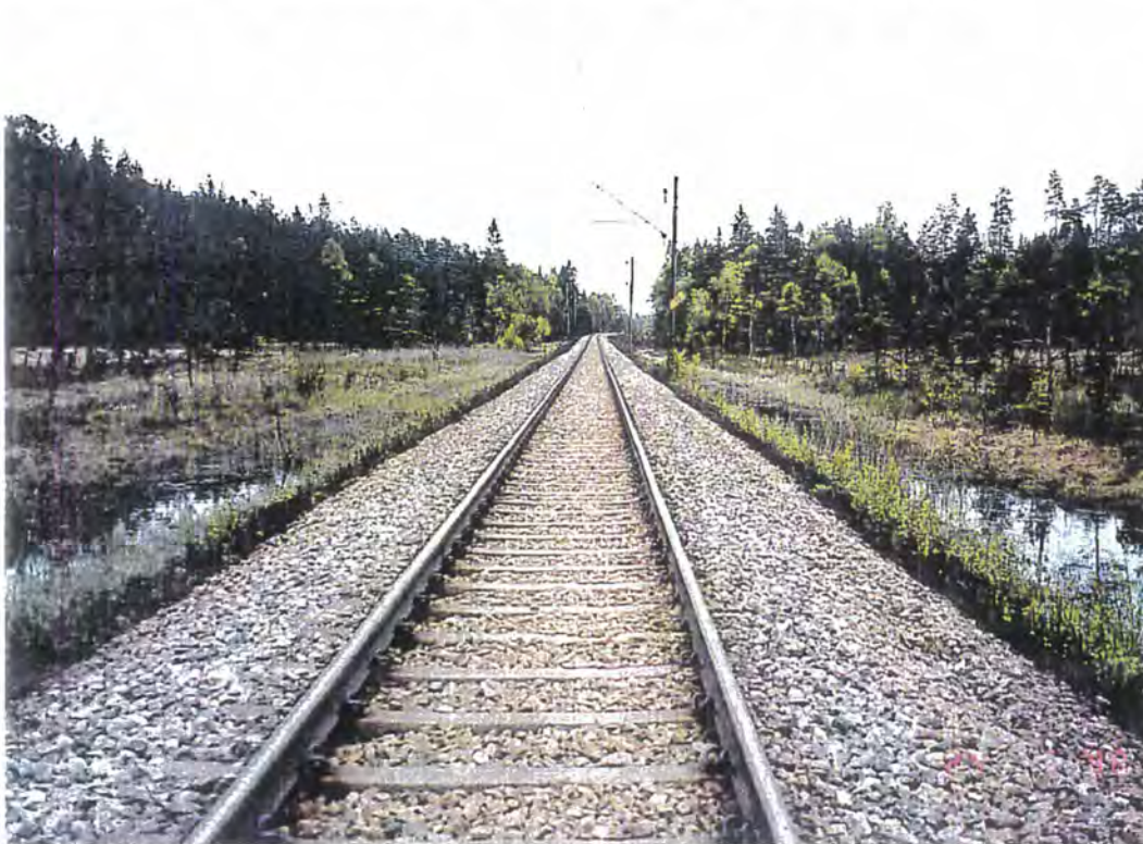
FIGUR 2-8 Jernbane på lav fylling over bløte myrområder ved km 153,3
