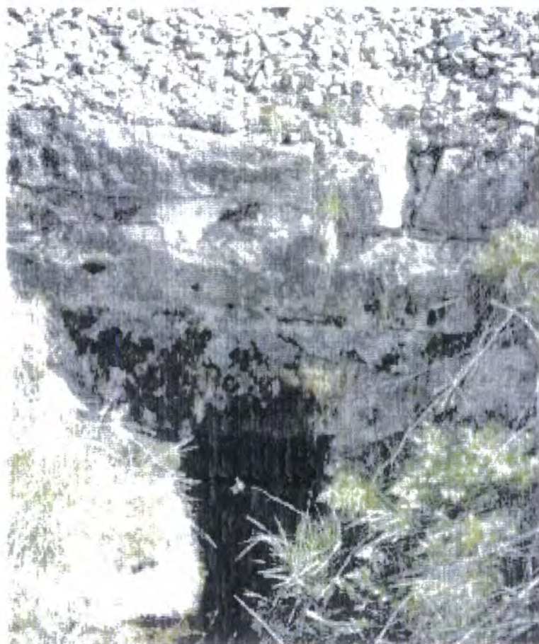
FIGUR 2-2 Steinrenne med bra tilstand ved km 16,588
