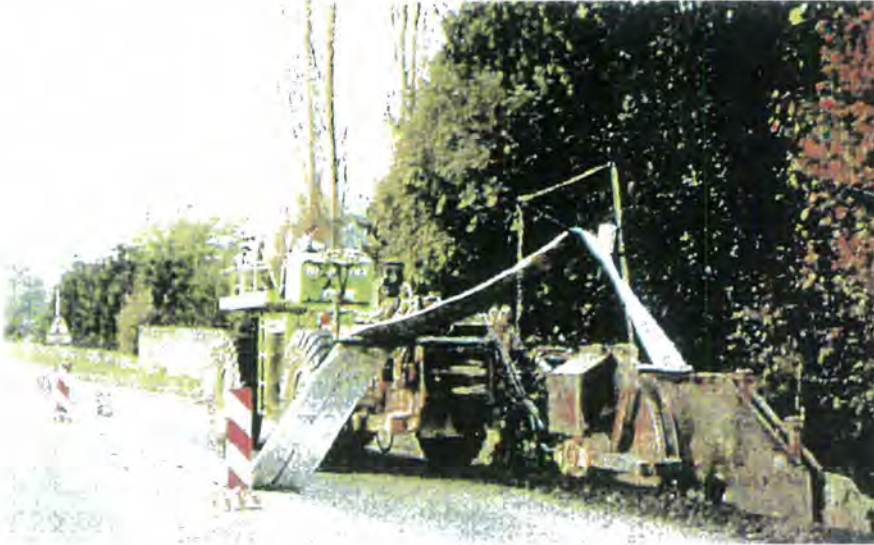
FIGUR 4-18 Eksempel på utstyr for nedgraving av drensmatte
