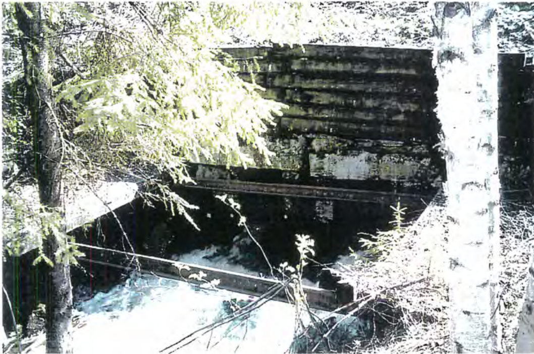
FIGUR 4-9 Mur av tresviller for å hindre nedrasing i stikkrennas utløp
