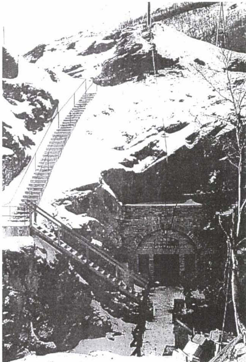
Foto 7: Kongsvoll kraftstasjon øverst i Drivdalen produserte elektrisk kraft til fjellstuene og NSB's anlegg på høyfjellet til langt ut på 1960-tallet. Kraftstasjonen var så lenge damplokomotivene gikk en forutsetning for driften over fjellet.
