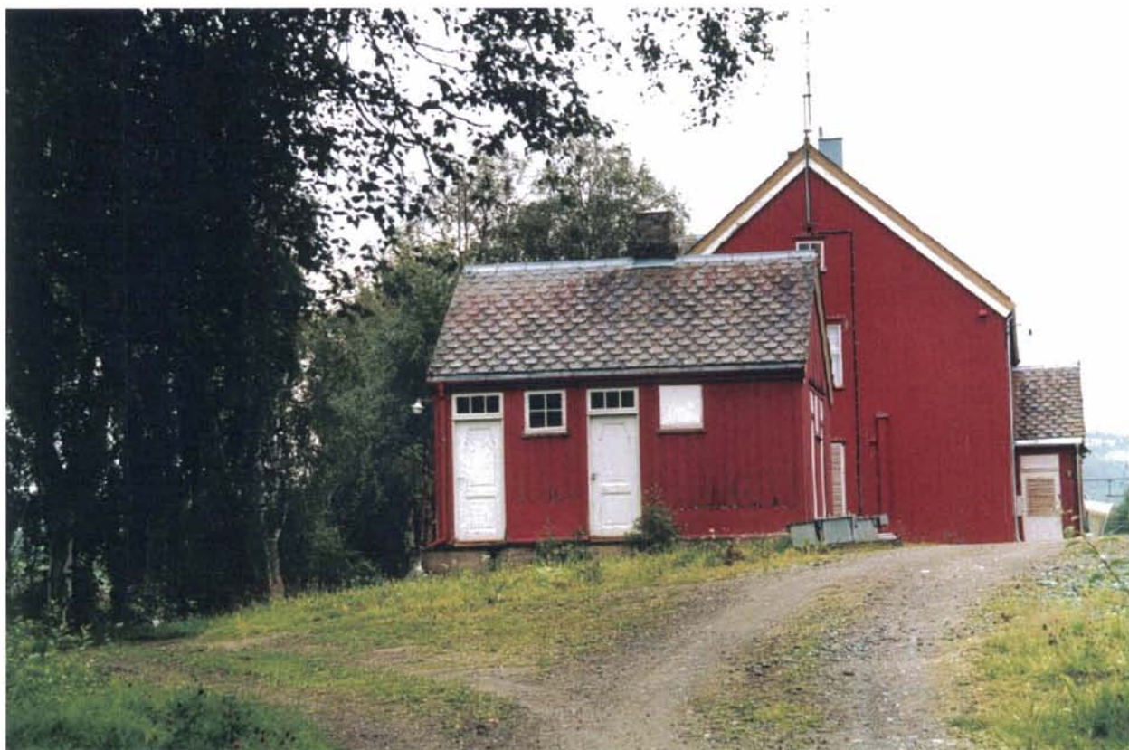
Foto 19: Soknedal stasjons adkomst fra nord. Det velkjente mønsteret med gjennomgående adkomstveg finner vi også her. Vegen er avgrenset av stabbesteiner og en rekke med bjørketrær mot dalen. Med noen unntak er utomhusanlegget godt bevart. Bl.a må stasjonens grinder settes i stand.
