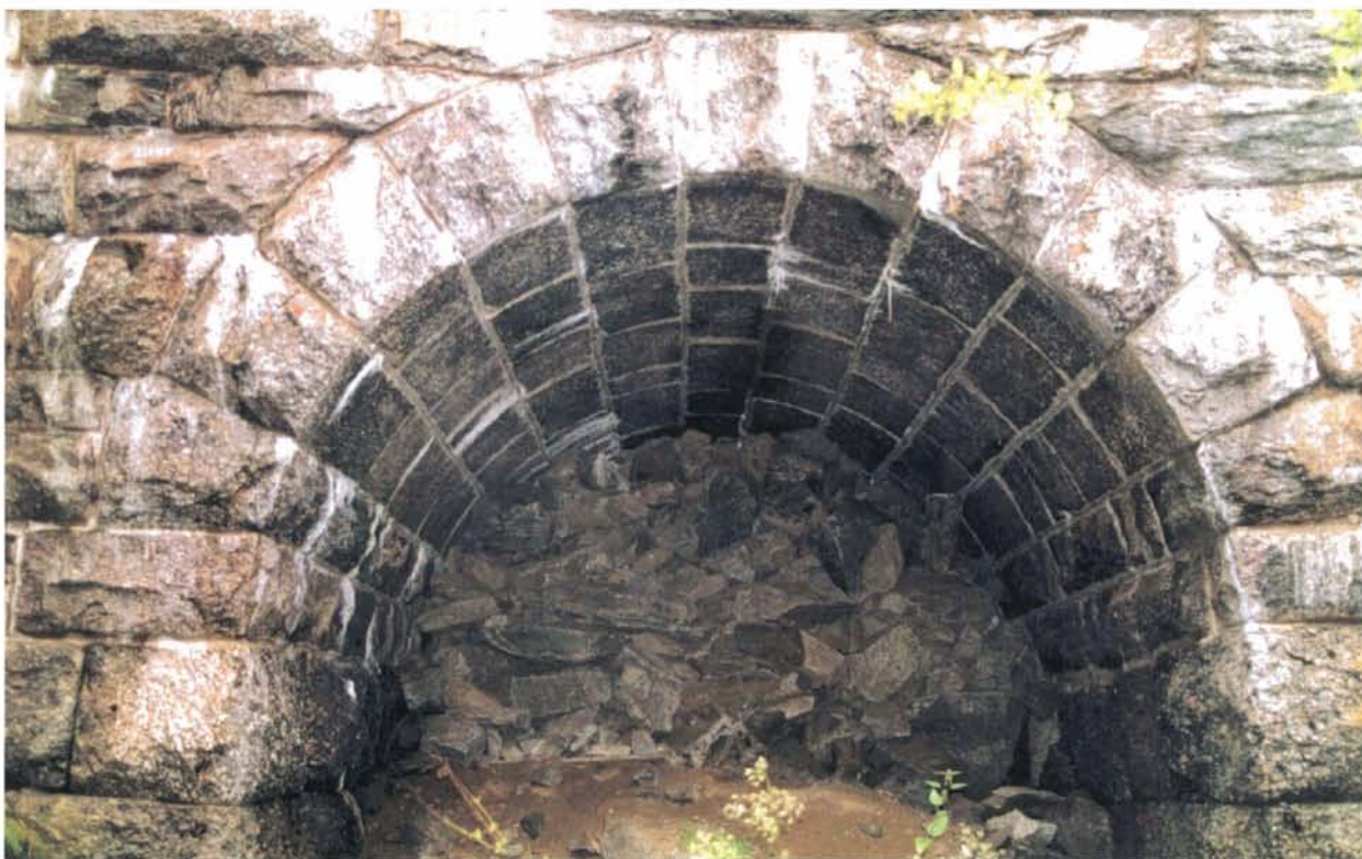
Foto 50: Den gjenfylte kulverten ved Drivstua er et talende eksempel på den mangel på respekt som i vår tid er utvist overfor tidligere generasjoners flid og omtanke for miljø og landskap. Kulvertrestene er slik sett et "kulturminne" i seg selv fra epoken 1960-90.
