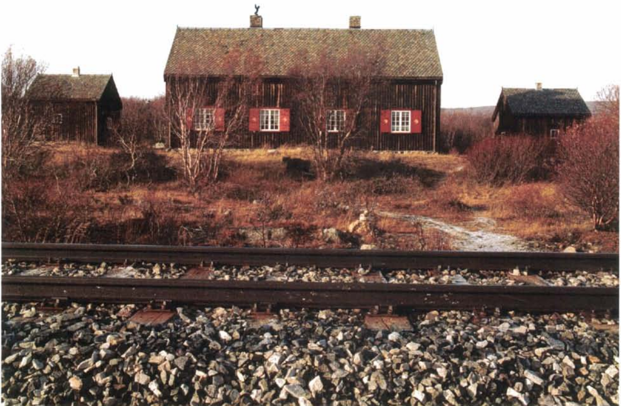
Foto 22: Lesjabekk vokterbolig, km 367,95, står på NSB's bygningsverneplan. Fôrlått og beiting har opp igjen gjennom årene gjort at de åpne arealene rundt husene har blitt til frodige grasvoller. Nå som vokterboligene er fraflyttet og beitingen opphørt, invaderes de åpne arealene igjen av fjellbjørkeskogen. For helhetens skyld er det viktig at disse vollene holdes åpne ved at kratt fjernes og gras slås hver sommer.
