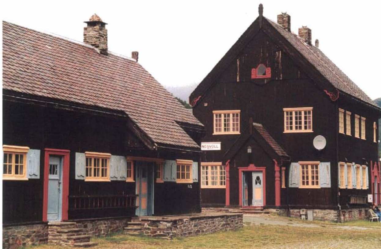
Foto 12: Stasjonsbygningen på Kongsvoll er et smykke av en bygning og er sammen med godshuset og stasjonens perrong og hage fredet med hjemmel i Kulturminnelovens §§ 15 og 19. Bygningene er tegnet av Erik Glosimodt og sto ferdig i 1921. Også stedets vokterbolig fra 1911 er godt holdt i hevd og supplerer stasjonsmiljøet på en fin måte (jfr. foto 25 og 26).
