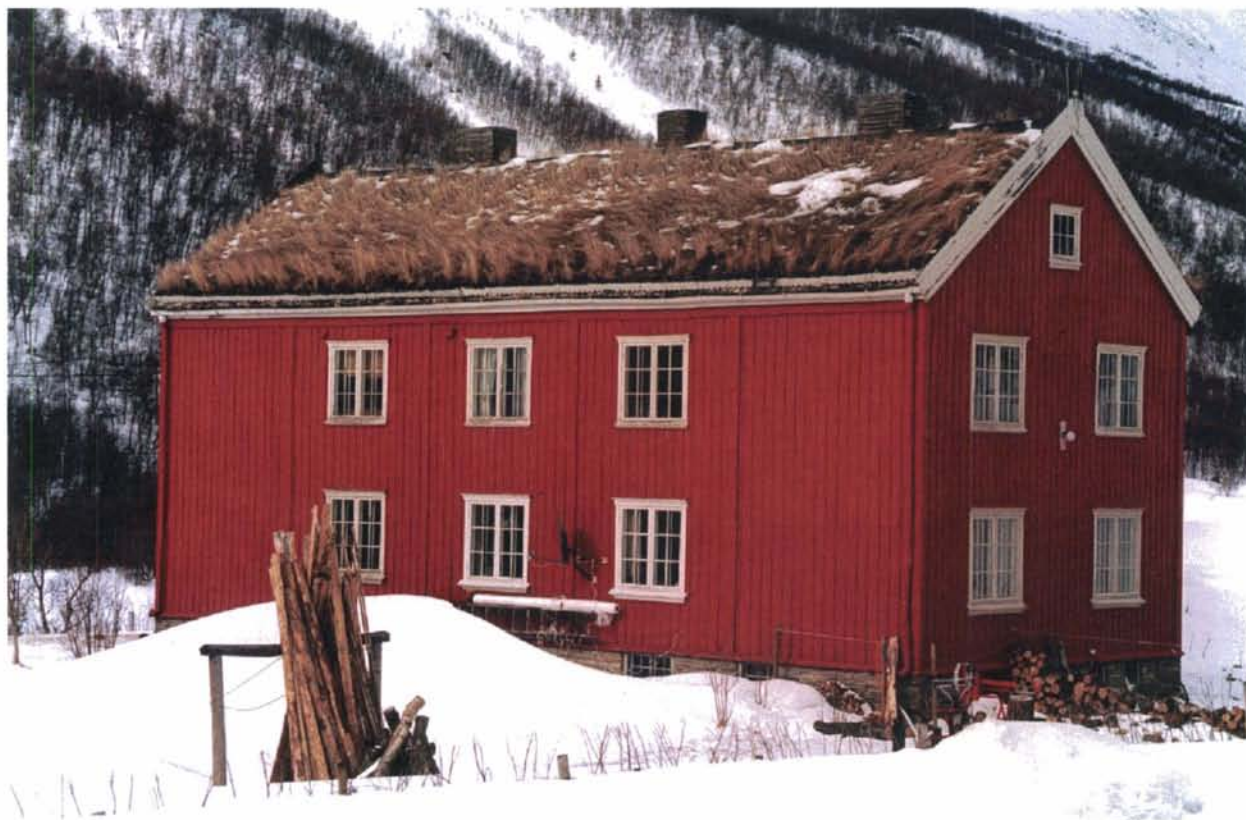
Foto 33: Betjentboligen og skolehuset ved Drivstua stasjon bør pålegges vern i medhold av bestemmelser hjemlet i Plan- og bygningsloven og tas vare på/vedlikeholdes som en del av det kulturhistoriske miljøet ved Drivstua. Bygningene er administrativt vernet i NSB's verneplan.
