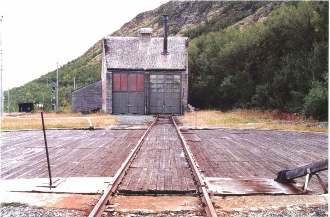
Foto 62: Lokomotivstallen på Hjerkins stasjon ble oppført i 1920-21 etter tegninger av NSB arkitektkontor v/arkitekt Båstad. Stallene på Hjerkins og Drivstua skal ha vært de første bygningene som ble bygget av oppdalsskifer. Skiferforblendingen gir bygningen tyngde og verdighet. Hele dette anlegget med svingskive og spor inngår i fredningen av Hjerkins stasjon.
