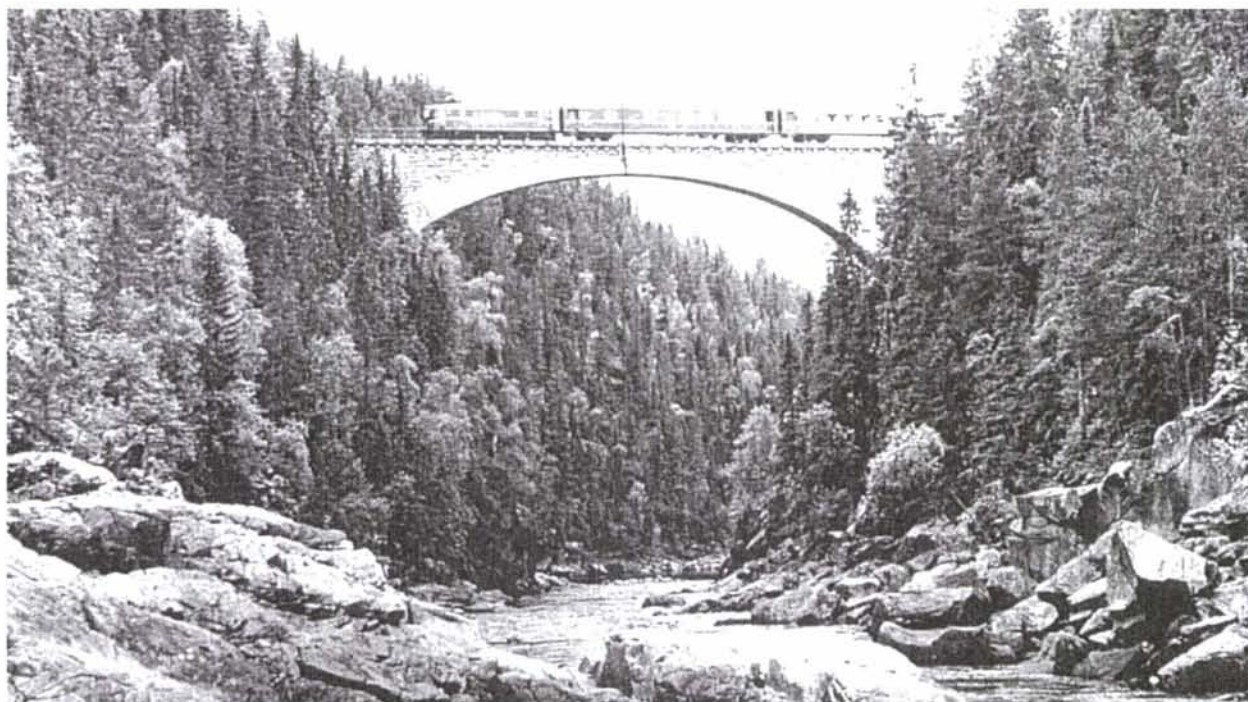
Foto 1: Dovrebanen ble bygget i en periode hvor Statsbanene hadde mange dyktige steinhoggere i sin tjeneste. Den mektige brua over Orkla er den lengste steinhvelvbru på det norske jernbanenettet. Brua ble bygget i 1911-15 og er 84 meter lang med et hovedspenn på 60 meter.
