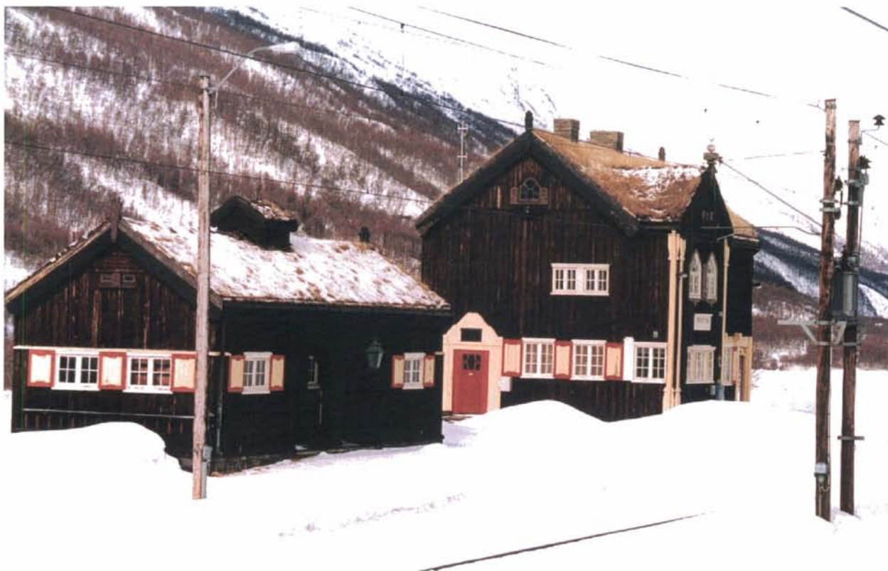
Foto 13: Drivstua stasjon er den nordligste av stasjonene som ble tegnet av Erik Glosimodt. Stasjonen ligger der landskapet åpner seg i et dalrom nordover mot Engan og er en milepæl for både vegfarende og togreisende på turen over fjellet. Bygninger og anlegg med perrong, grunder og gjerder m.v. er fredet i medhold av Kulturminnelovens §§ 15 og 19.
