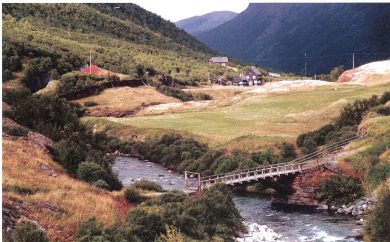
Foto 29: Ved Kongsvoll snevres landskapet inn før jernbanen "stuper utfor" Dovreplatået og ned Drivdalen. Jernbanens hus og anlegg gir sammen med fjellstua og det åpne kulturlandskapet stedet identitet som milepæl på reisen over Dovre. Dette kulturmiljøet utgjør en del av Kongsvoll landskapsvernområde.
