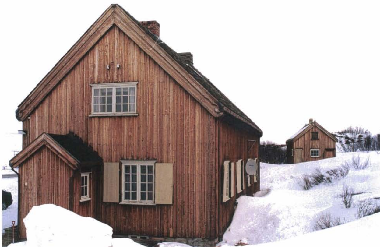
Foto 24: Svonå vokterbolig, km 387,03, ligger like ved E6 nord for Hjerkinn. Bygningene er fremdeles i NSB BA's eie og brukes som ferieboliger. Også disse bygningene er en del av et usedvanlig godt bevart bygningsprogram på Dovrebanens høgfjellsstrekning som må tas vare på for ettertiden.
