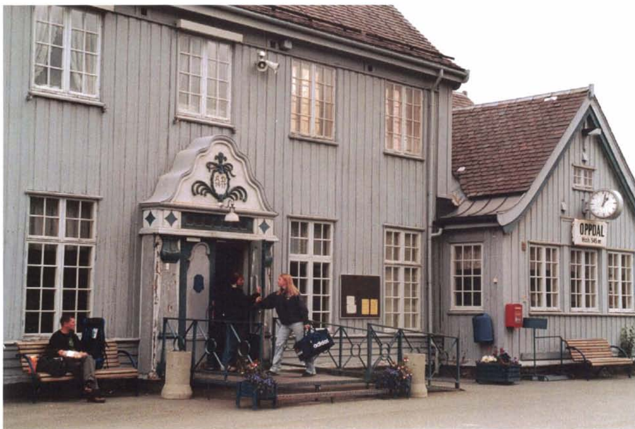
Foto 14: Stasjonsbygningen og turisthotellet (foto 15) gir Oppdal stasjon en sterk identitet som man må vite å bygge videre på når stasjonsanlegget skal videreutvikles. Eventuelle ombygginger/påbygginger må skje med respekt for stasjonsbygningens arkitektoniske uttrykk og bygningens fint oppdelte bygningskropp.
