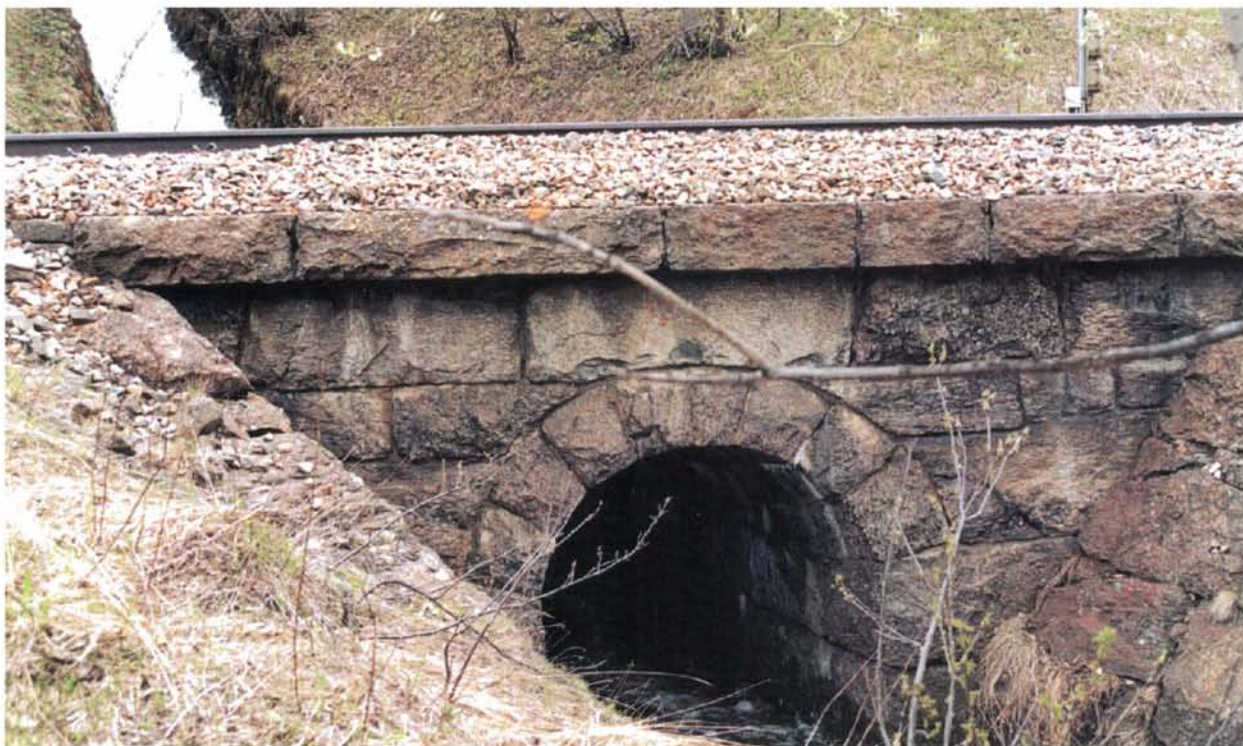
Foto 49: Bekkekulvert av naturstein ved km 406,09. Bekken og kulverten er et skue ved stor vannføring. Nedstrøms bør det steinsatte bekkeløpet reetableres og et betonglokk som ble lagt over bekken på 1950-tallet rives opp. En skjøtselsplan med formål å bevare mest mulig av jernbanens opprinnelige anlegg på dette partiet av Drivdalen utarbeides som del av en omfattende områdeplan.
