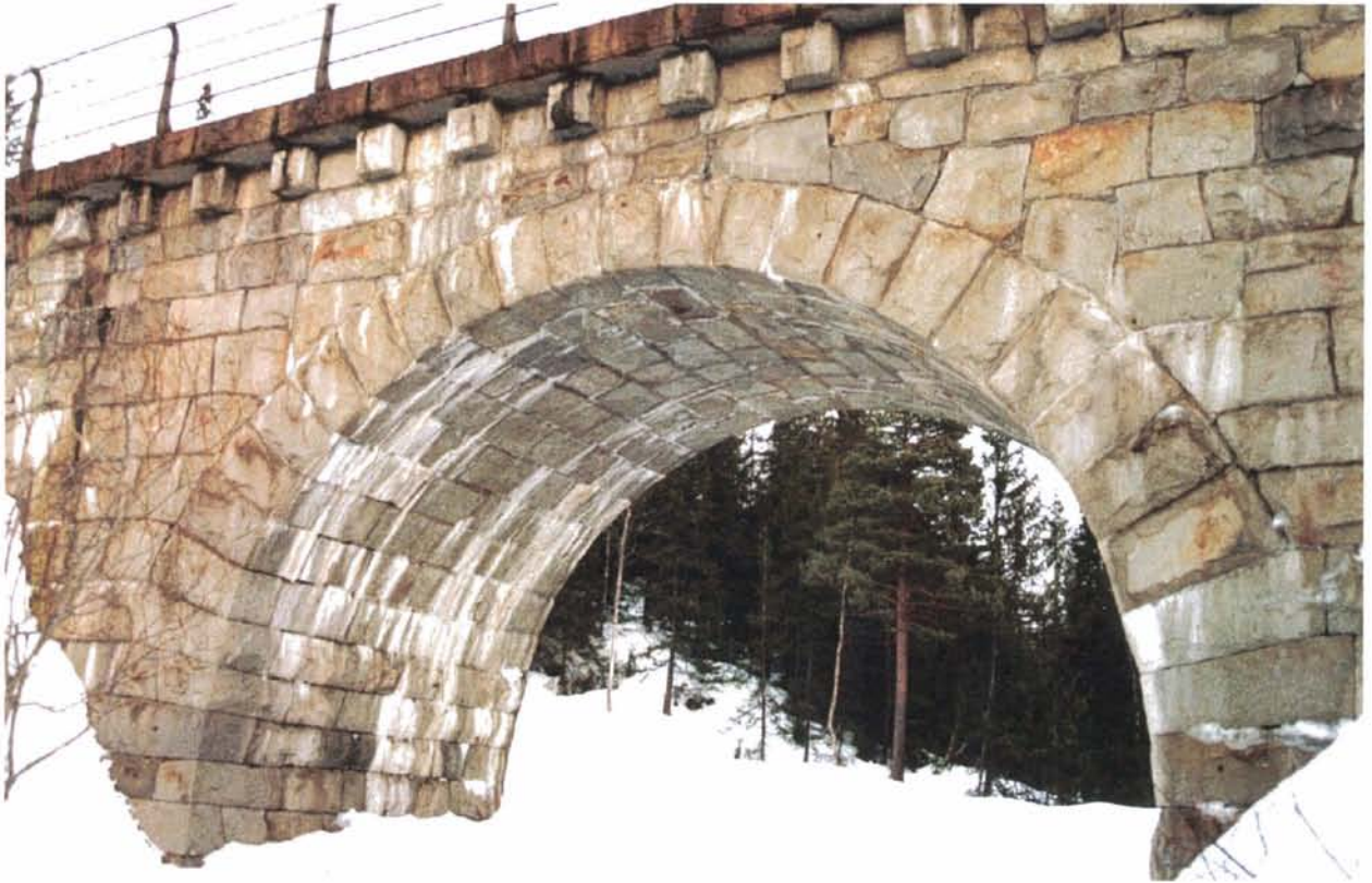
Foto 44: Brua over Skauma som spenner over både elv og veg er en konstruksjonstype som vi finner flere av både på Nordlandsbanen, Dovrebanen og Raumabanen. En mindre utgave som spenner over en tursti og en bekk blir belagt med vern på Grønbakken (side 47).
