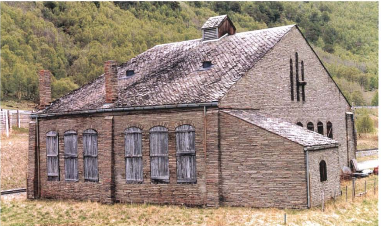
Foto 63: Svingskiven til Drivstua lokstall ble flyttet til Røros i forbindelse med Rørosbanens omlegging til normalspor i 1941. Stallen har fremdeles sitt tak, sine vinduer og porter i behold og utgjør en viktig del av det historiske miljøet ved Drivstua (jfr. også foto 6). Sporveksel og hensettingsporet som fører i retning stallen må bevares slik at stallsporet kan gjenskapes.
