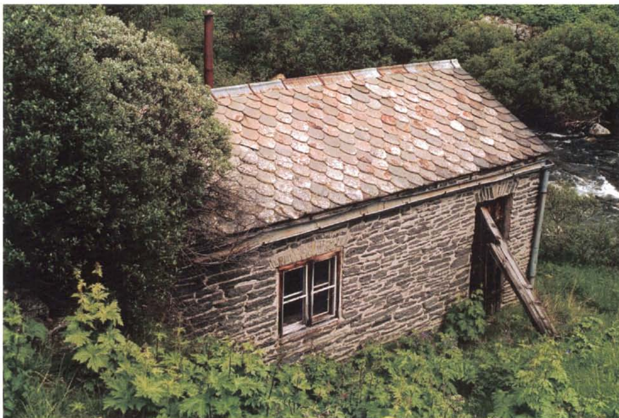
Foto 58: Pumpehuset ved Kongsvoll stasjon, km 393,02, er allerede pålagt administrativt vern i "Verneplan for jernbanebygninger" og skal forvaltes som et kulturminne. Huset er godt holdt vedlike og både dieselaggregatet, pumpen og en vedovn er bevart på stedet.
