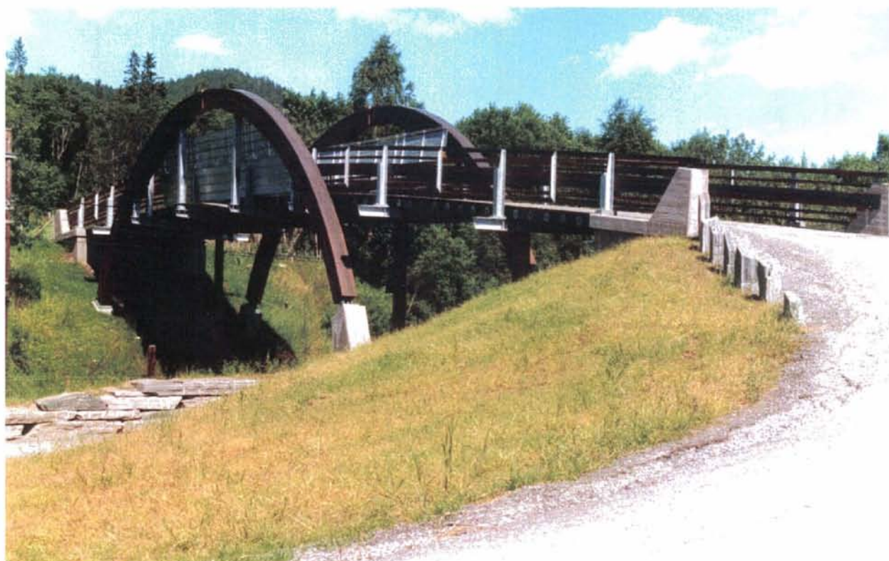
Foto 45: Den nye overgangsbrua i Soknedalen, km 488,30, er bygget av limtre og er et eksempel til etterfølgelse når Dovrebanens anlegg nå skal gjennomgå en oppgradering i forbindelse med satsningen på krengetog. Er dette morgendagens kulturminner bygget i dag?
