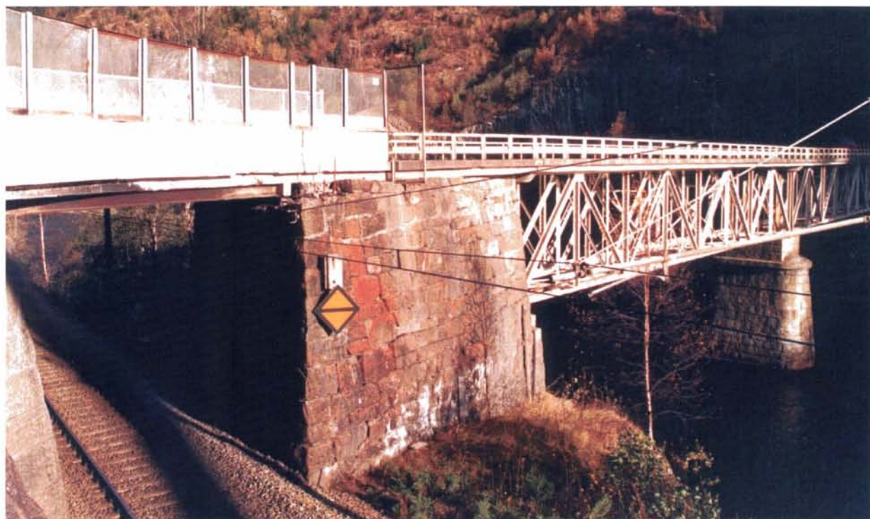
Foto 40: Det kan bli aktuelt å erstatte nåværende betongbru over jernbanen (til venstre) med ei lettere bjelkebru i stål og tre dersom Haga vegbru vedtas restaurert som vegminne.
