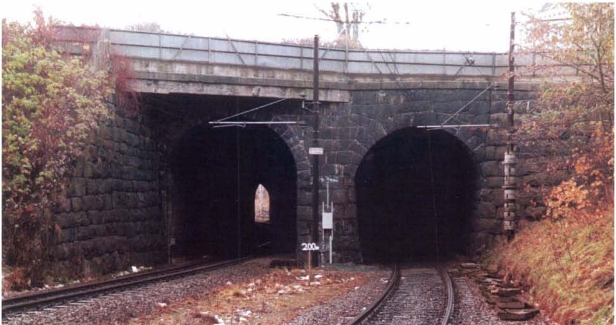
Foto 42: Tunnelene under Ilevollen danner et skarpt landskapsskille mellom Nidelvas grønne elvekorridor i sør, og bylandskapet, havna og det åpne fjordlandskapet på nordsiden. Tunnelportalene er fint utført i tilhøgd naturstein. "Byporten" har lokal og nasjonal verneverdi og må bevares som en integrert del av bylandskapet.
