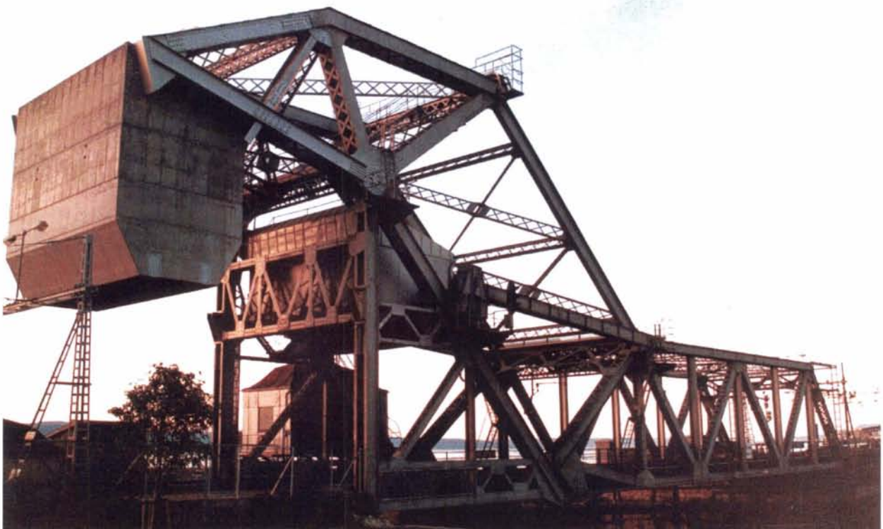
Foto 37: Skansen bru er ei imponerende stålbru basert på Strauss' patenterte motvektsprinsipp. Brua veier totalt 1055 tonn hvorav motvektssloddet alene hele 560 tonn! Dette er den eneste klaffebrua som fortsatt daglig er i bruk på det norske jernbanenettet.
