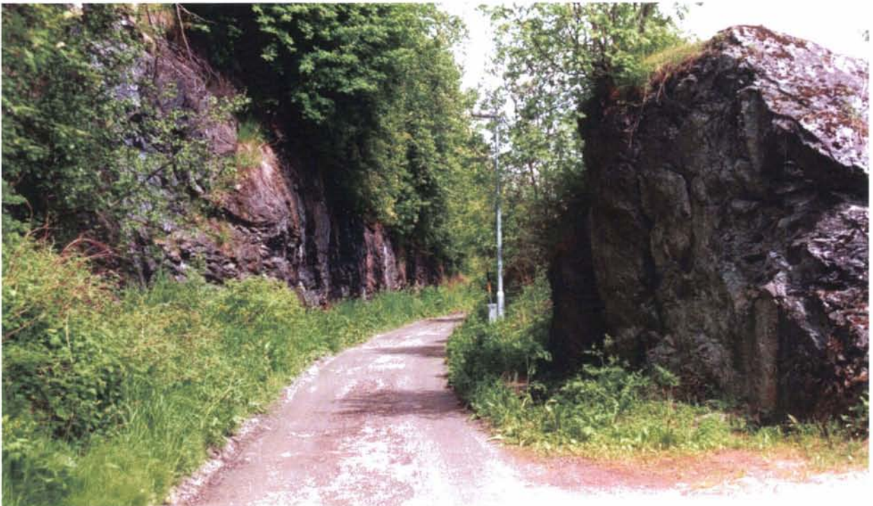
Foto 27: Fra "Gammellina" på Selsbakk. Traséen er i dag omgjort til veg, men den gamle jernbanetraséen har fremdeles sitt umiskjennelige smalsporprofil i behold.
