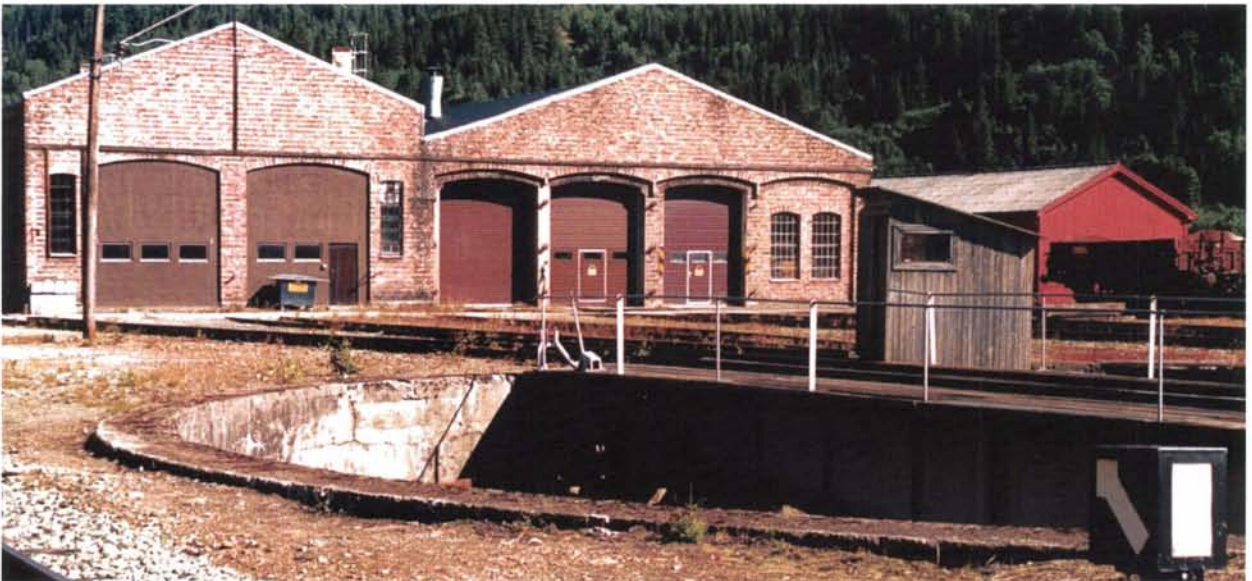
Foto 16: Beliggenheten i skjæringspunktet mellom Dovrebanen og Rørosbanen, de gamle verkstedbygningene, lokstallen m.v. gjør Støren velegnet som tilholdssted for et miljø med formål å ivareta og forvalte gammel jernbanetradisjon. Støren kan for eksempel utvikles til et senter for aktiviteter omkring lagring, istandsetting og vedlikehold av utrangert materiell og utstyr. Bygninger og areal som blir frigitt fra det ordinære banevedlikeholdet bør tas vare på og forvaltes med dette for øyet. Gamle skinner og befestigelse, maskiner og håndverktøy, perrongstein og heller, skilt, dører, porter og andre driftsremedier og bygningselementer må tas vare på for bevaring eller ombruk. Det anbefales at behovet for slike landsdelsanlegg for oppsamling, mellomlagring og vedlikehold av brukt/musealt materiell tas opp til diskusjon i landsverneplanen.
