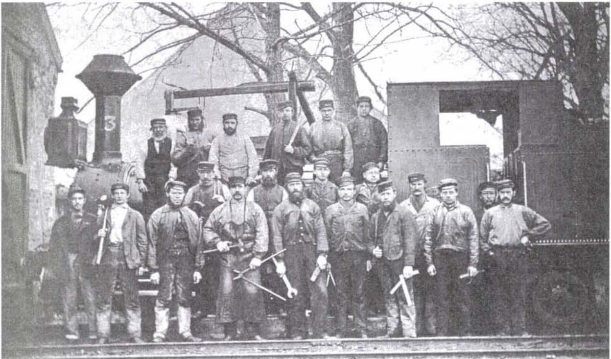
Foto 3: "Hakon" (lok nr. 3) ble levert til Størenbanen i 1864 og var for sin tid et meget avansert lokomotiv. Bl.a. var loket utstyrt med radierende løpeaksler foran. De tekniske spesifikasjonene ble angitt av C. A. Pihl og lokomotivet ble bygget ved Slaughter-Grüning & Co i England (mer velrenommerede fabrikanter som Stevenson hadde ikke tilstrekkelig tro på produktet til å ta på seg oppgaven). Det første norskproduserte lokomotivet, "Thrønderen" (nr. 2), ble levert til anlegget allerede i 1862 og var bygget av Fabrikken ved Nidelven. Dette var i konstruksjon mye likt datidens engelske lokomotiver og ble aldri noen stor suksess. Det ble utrangert allerede i 1874. Fotoet av "Hakon" er tatt på Kalvskinnet i 1870.
