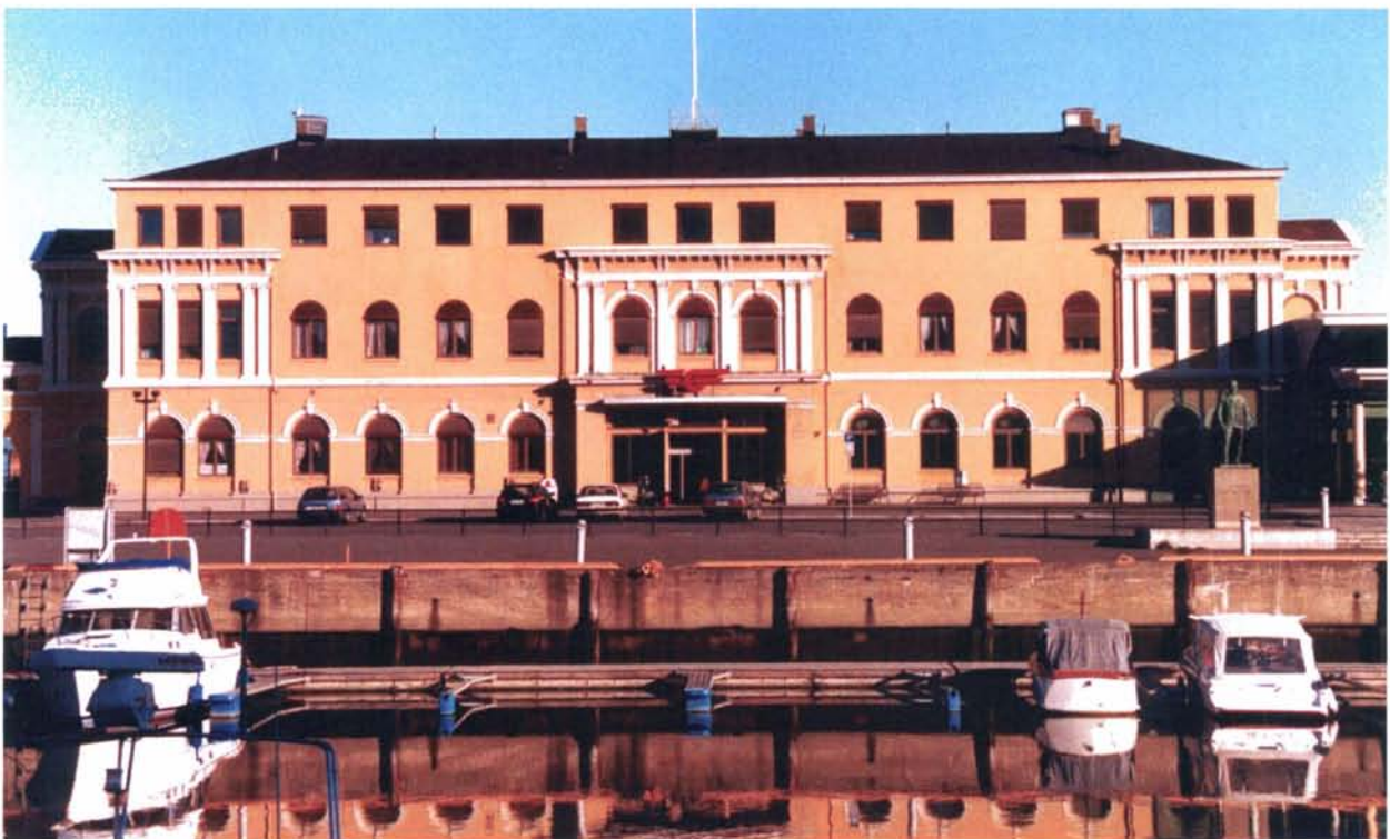
Foto 25: Etter at Fosen Trafikklags bygg foran den gamle trafikkhallen ble fjernet i 1994, har Trondheim stasjon igjen trådt inn i bybildet på en positiv måte. Pga. flere ombygninger har imidlertid stasjonsanlegget mistet mye av sin kulturhistoriske verdi. En arkitektonisk og bygningsmessig opprydding er sterkt å anbefale når stasjonsanlegget i nær framtid skal oppgraderes for nye oppgaver.
