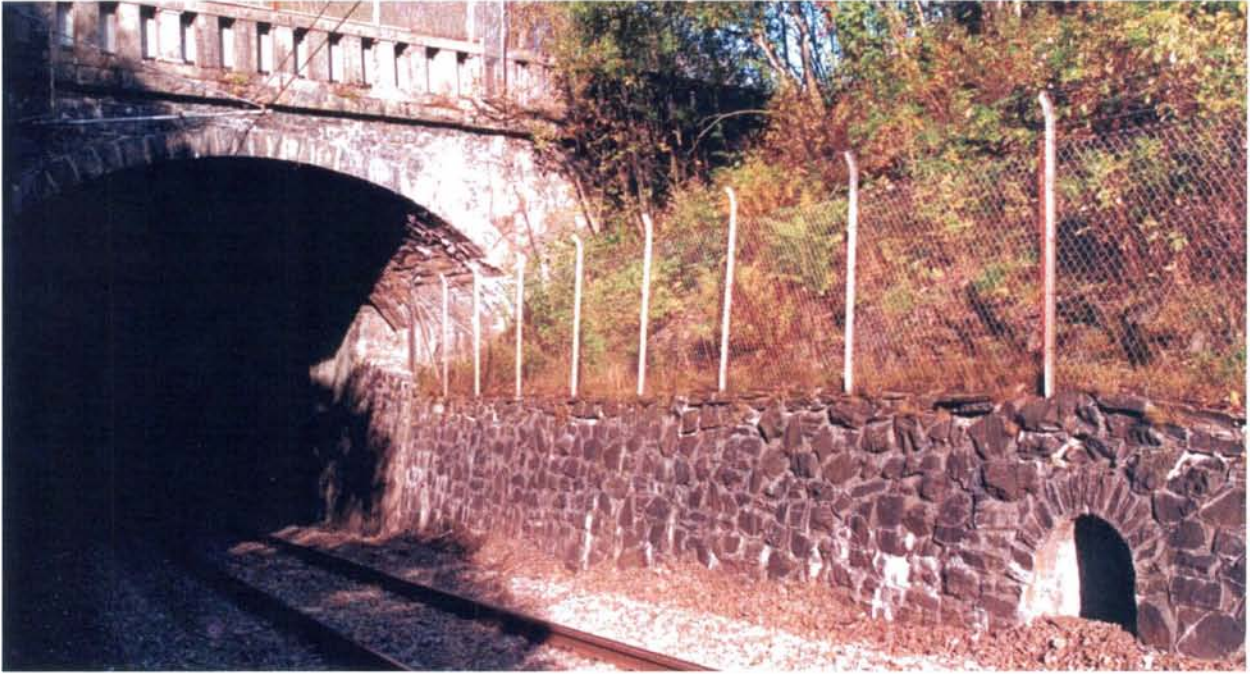
Foto 41: Søndre portal til Gulfoss tunnel omrammes av et av hvelvene til Gulfoss vegbru. Brua er verneverdig (Statens vegvesen).
