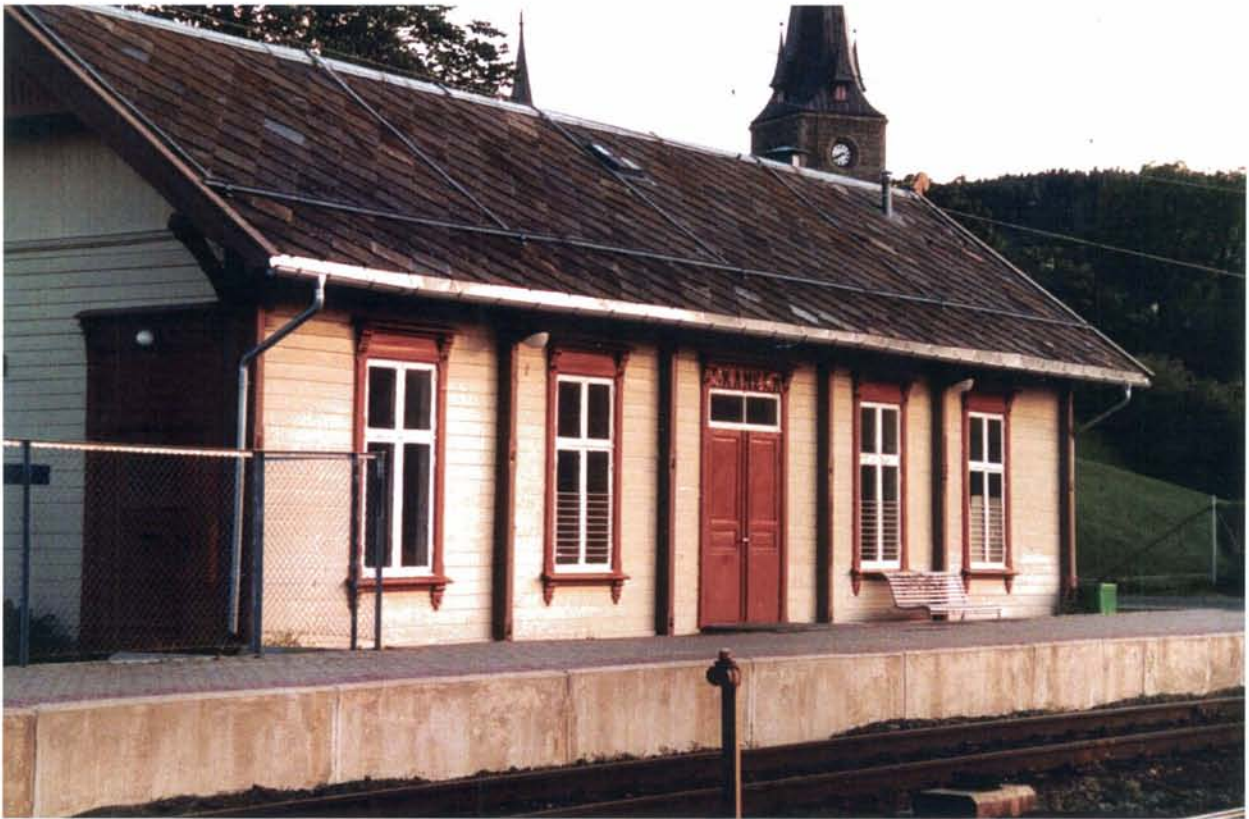
Foto 24: Skansen ekspedisjonsbygning fra ca. 1904 er tegnet av Paul A. Due i sveitserstil. Perrongen og ekspedisjonsbygningen er nyrenovert og godt vedlikeholdt. Plattformhevingen i 1997 har ført til at bygningen ligger nedsenket i forhold til perrongen. Dette bør rettes på ved å heve bygningen på en høyere grunnmur.
