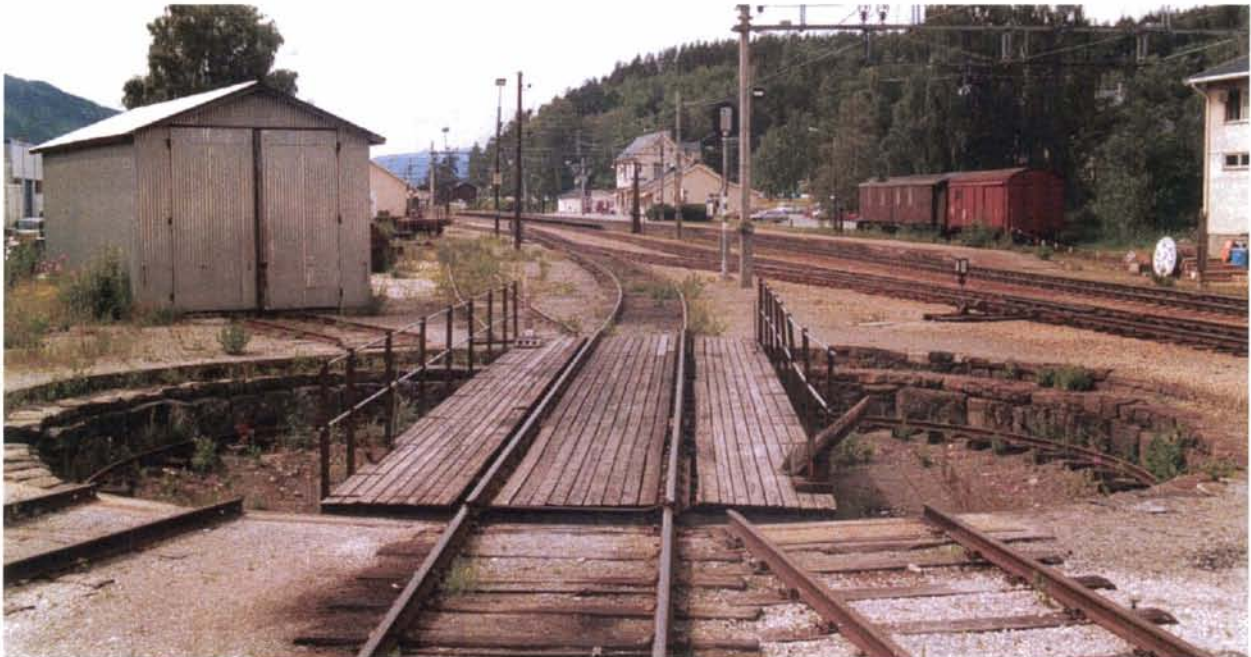
Foto 61: Svingskiva ved Ringebru er sjelden og bør tas vare på som et klenodium fra stasjonens tidligste år.
