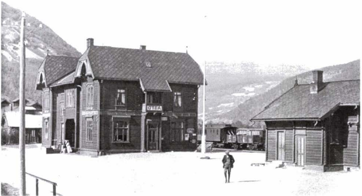
Foto 36: Otta stasjon slik den så ut på 1930-tallet. Stasjonsbygningen fra 1896 var spesielt utviklet for Otta og ble oppført i to fulle etasjer med tverrvendte arker på gavlene. Den var en videreutvikling av stasjonsbygningen på Flisa (vernet i "Verneplan for jernbanebygninger") som Paul A. Due hadde tegnet fire år tidligere, men med detaljer hentet fra den rådende dragestilen. Bygningen er senere ombygd til det ugjenkjennelige. De andre bygningene, ilgodshuset og privèten, er revet.
