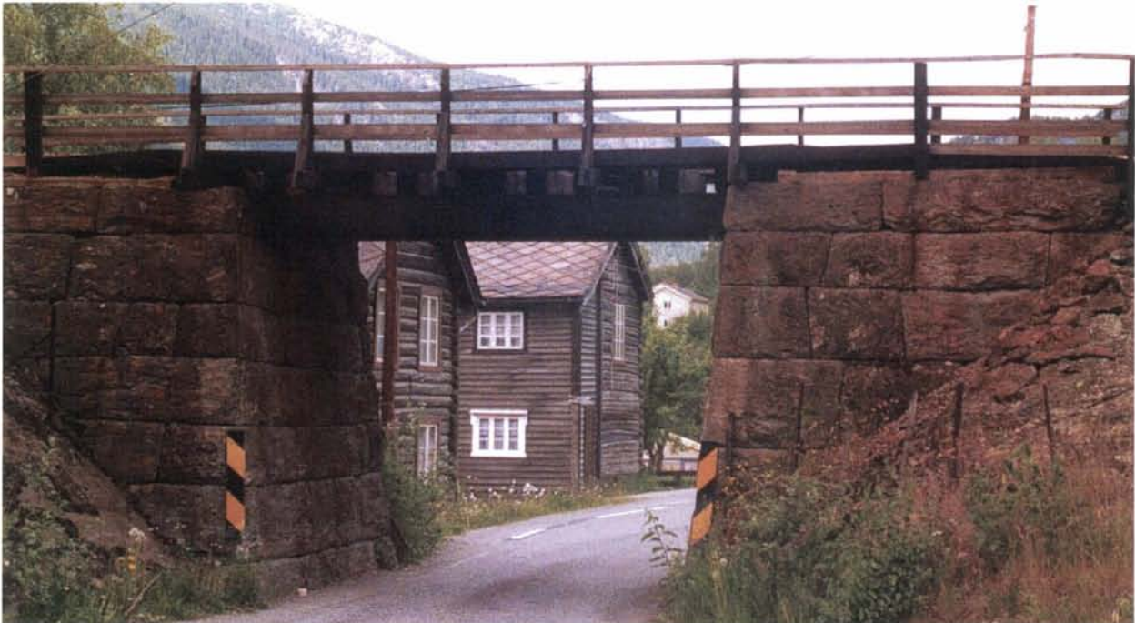
Foto 53: Stålbjelkebrua over gamle FV 257 ved Sjoa, km 286,16, har murverk av høg klasse. Bærerne i slike underganger erstattes nå med betongtrau (foto 52). Denne "kollisjonen" mellom to ulike byggeteknikker med forskjellig bruk av materialer er en utfordring som må finne sin løsning dersom Gudbrandsdalsbanens mange håndmurte kar ikke skal visuelt forsimples. Disse undergangene ligger der mennesker ferdes og vil forme folks oppfatning av Jernbaneverkets evne til å ta vare på godt og tradisjonsrikt håndverk.
