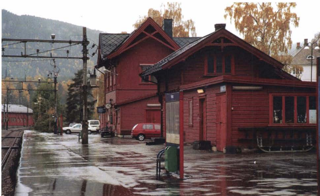
Foto 31: Vinstra stasjonsbygning og ilgodshus høsten 1998 med sine tilbygg fra 1950-tallet. Stasjonsbygningen er frarøvet de fleste av sine fasadedetaljer og er forandret til det ugjenkjennelige. Det skifertekte taket, alle vindus- og døråpninger er imidlertid på plass og forteller at tross alt er dette en "sovende skjønnhet" hvor en historisk tilbakeføring vil være mulig.
