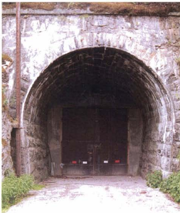
Foto 59: Gamle Randklev tunnel vernes i "Nasjonal verneplan" som et teknisk kulturminne fra Gudbrandsdalsbanens tidligste periode. Vernet må sees i sammenheng med Randklev bru (se side 50).
