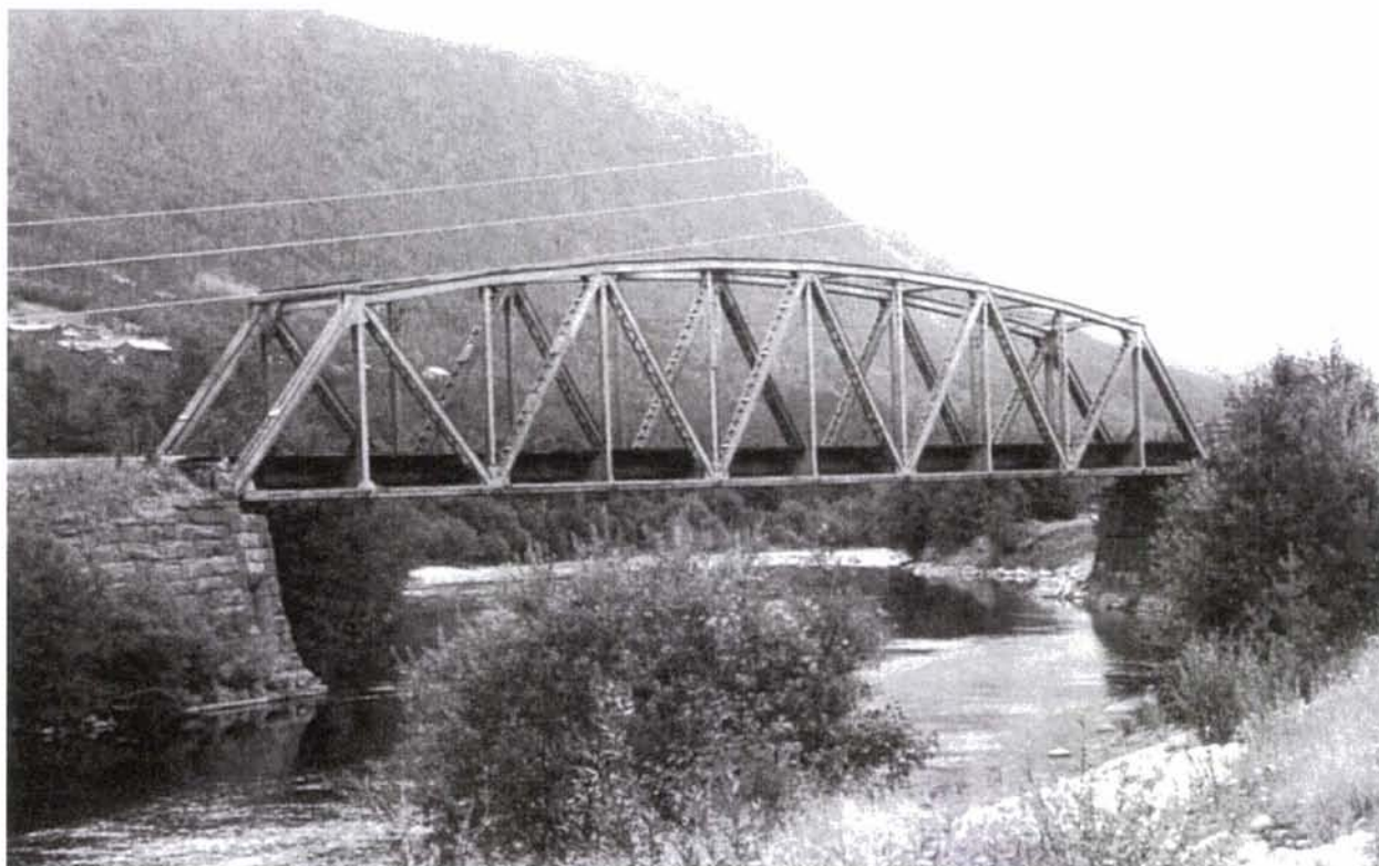
Foto 47: Brua over Lågen ved Tallerås har sitt fagverk fra 1912 i behold.
