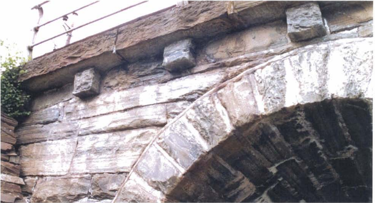
Foto 54: Det var rundt forrige århundreskifte at man for alvor begynte å bygge hvelvbruer av stein her i Norge. Byggemetoden endret seg over tid, fra ren tørrmur i de første hvelvene som ble bygget rundt 1880, via bruddstein i sementmørtel som ble den vanligste byggemetoden fra ca. 1900. Steinhvelvene på strekningen Otta-Dombås er alle bygget etter denne metoden og representerer håndverk av høy klasse. Fotoet er av undergangen på Tallerås, km 327,90.
