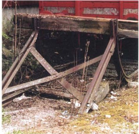
Foto 63: Stoppbukke på Tretten bør tas vare på som en del av kulturmiljøet ved stasjonen; på sin nåværende plass eller flyttet til et annet buttspor.
