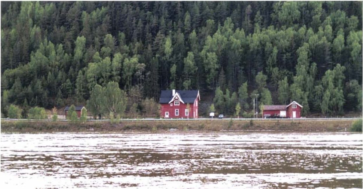
Foto 22: Fåvang stasjon fotografert fra E6 i år 2000. Situasjonen er ikke vesensforskjellig endret siden 1896. Stasjonen er en milepæl på reisen gjennom Gudbrandsdalen og har stedsverdi. Anlegget foreslås ikke pålagt noe formelt vern i "Nasjonal verneplan", men anlegget bør bevares.
