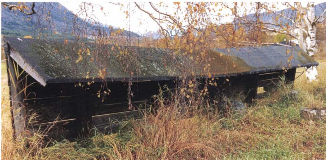
Foto 66: Stigestativet ved Dovre bevares som en del av stasjonsmiljøet.
