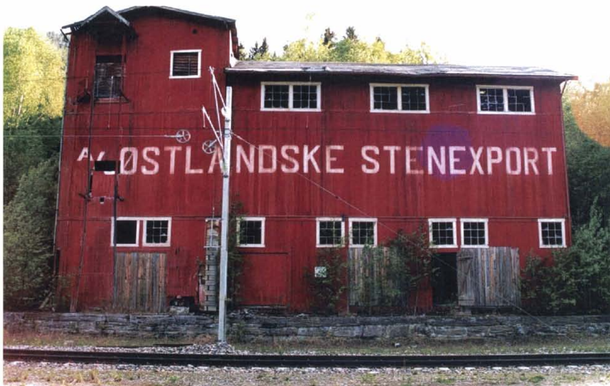
Foto 38: "A/S Østlandske Stenexports" omlastingsanlegg på Sel. Anlegget har lokalhistorisk betydning. Bygningen preges av forfall og det er usikkert om den lar seg bevare. To sidespor og en større lasterampe i stein ble revet så sent som i 1996.
