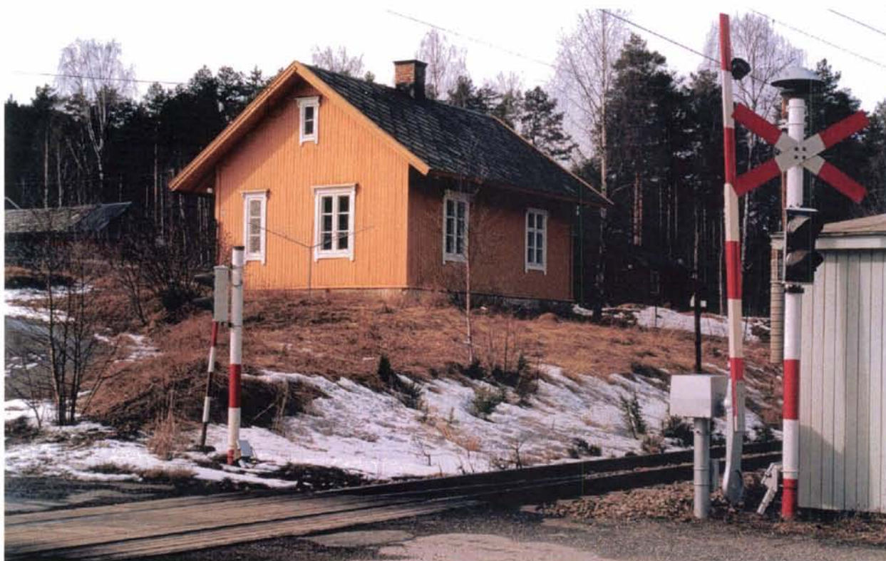
Foto 14: Planovergangen og vokterboligen nord for Øyer stasjon utgjør en viktig del av det gjenværende jernbanemiljøet, selv om bomanlegget som i sin tid erstattet de opprinnelige grindene er fra vår tid. Dersom togdriften krever at planovergangen legges ned kan det være vel så aktuelt å flytte bygningene til museum fremfor å påkoste stasjonen ny tilkomst.
