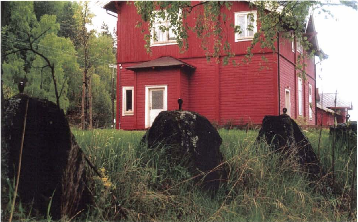
Foto 67: Istandsettingen av uteanlegget rundt Fåvang stasjon i 1993 ble ufullstendig utført. Rester av det gamle stasjonsanlegget, bl.a flere stabbesteiner, står imidlertid igjen og bør gi inspirasjon til å fullføre arbeidet på en verdig måte.
