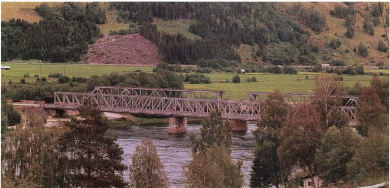
Foto 48: Tvillingbruaene ved Randklev oppleves som et helhetlig landskapselement fordi formspråket er felles. Bruene forteller jernbanehistorie og er fremragende eksempler på stålbruer av fagverk som det ble bygget så mange av i Gudbrandsdalen fra 1890-tallet og fram til 1957.
