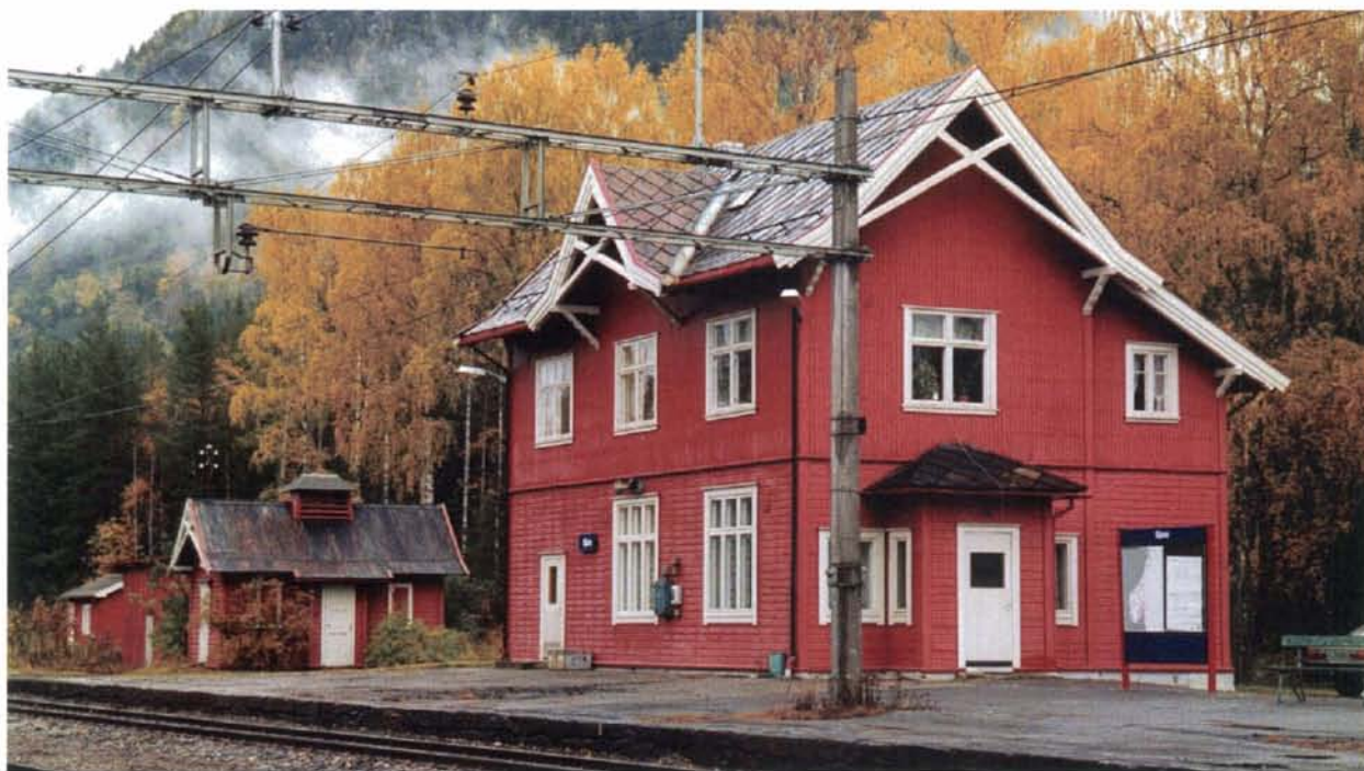
Foto 35: Stasjonsbygning og privèt ved Sjoa stasjon står på "Verneplan for jernbanebygninger". Stasjonen ligger imidlertid usentralt til og mangler elementer som man forventer å finne bevart i et stasjonsanlegg med vernestatus (bl.a mangler godshuset). Jernbaneverket vil derfor tilrå at privètbygningen på Sjoa flyttes til Tretten stasjon der bygningen kan komplettere et stasjonsanlegg i drift. Det bør også vurderes om Tretten stasjonsbygning kan erstatte stasjonsbygningen på Sjoa som eksempel på en "3die klasse Stationsbygning" på Hamar-Selbanen.
