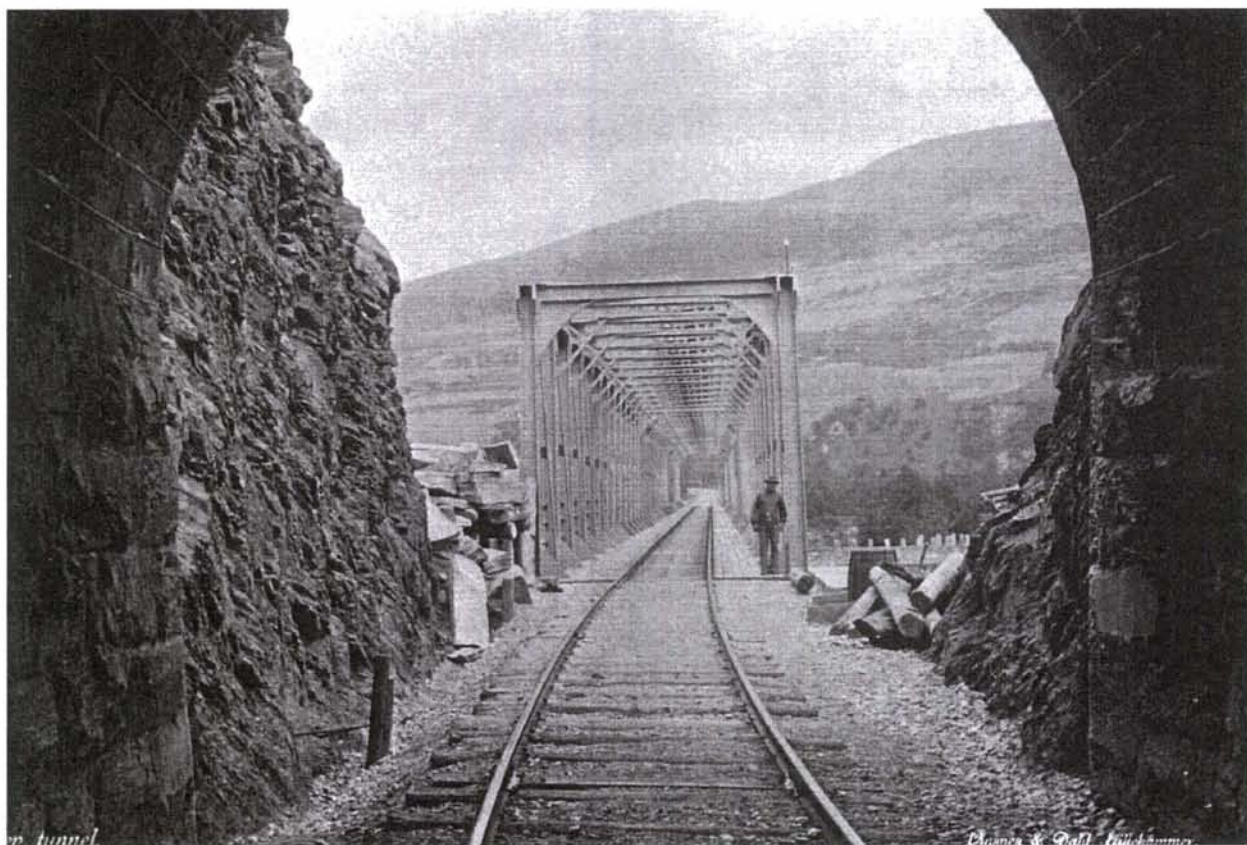
Foto 46: Utover på 1950-tallet måtte alle stålbruer på Hamar-Selbanen forsterkes eller bytte ut sitt stålfagverk til å tåle høyere aksellaster. Dette betyr at ingen av bruene mellom Lillehammer og Otta lenger har sitt opprinnelige fagverk i behold. Unntaket er Randklev bru hvor jernbanen ble omlagt og ny jernbanebru bygget parallelt med den gamle. Den gamle fagverksbrua er i dag i bruk som vegbru og eies av Statens vegvesen.
