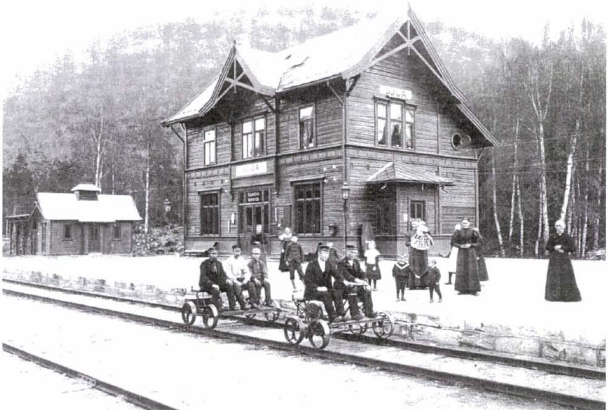
Foto 8: Paul A. Dues "3die klasse Stationsbygning" med godshus og privèt ved Sjoa fotografert ca. 1900. Stasjonsbygningen og privèten står fremdeles og er oppført på NSB's "Verneplan for jernbanebygninger". Privètbygningen er den siste gjenværende av sitt slag på Gudbrandsdalsbanen.
