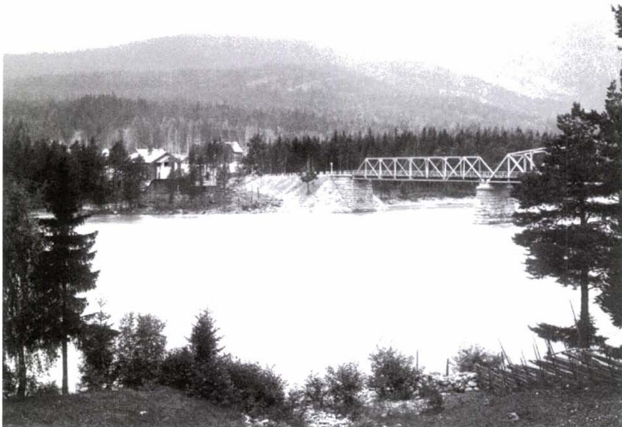
Foto 4: Stasjonene Øyer, Tretten og Fåvang (Myre) ble liggende på dalens "bakside" og måtte tilknyttes med ruer. De opprinnelige fagverksbruene ved Øyer og Fåvang (foto 5 og 6 på side 13) er senere revet og erstattet med betongruer. På Tretten derimot (fotoet over) er vegbrua fra 1895 fremdeles i bruk.
