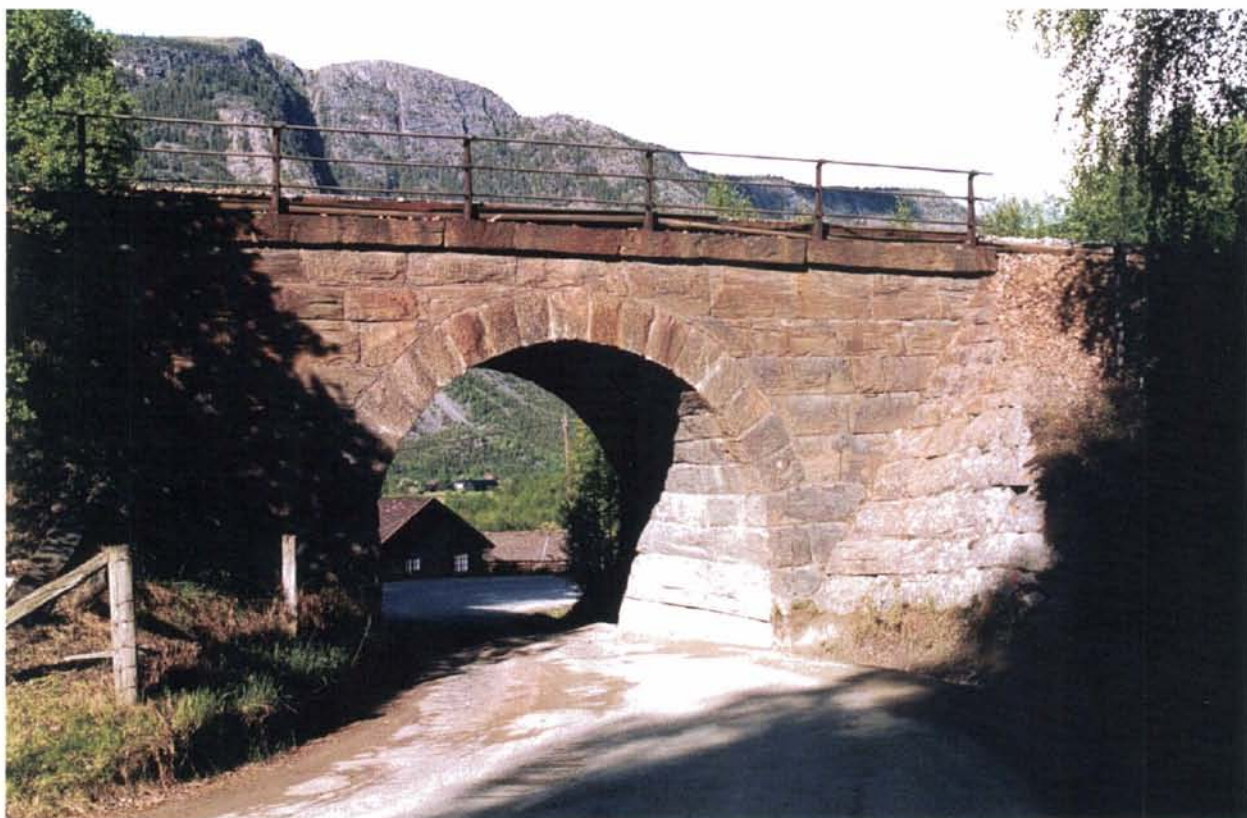
Foto 56: Undergangen for FV 438 i Nord-Sel er murt av lokal stein og utgjør sammen med et parti av Vågåvegen et usedvanlig flott kulturmiljø fra tidlig 1900-tall. Dersom vegen blir vernet som kulturminne (Statens vegvesen) vil det være naturlig at undergangen inngår.
