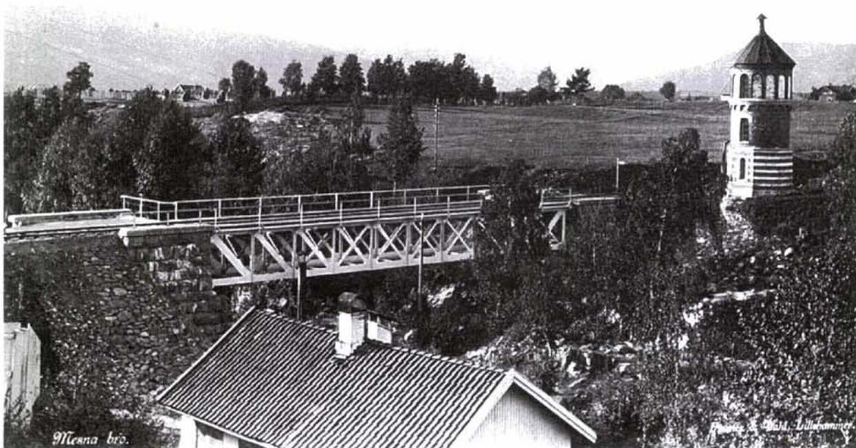
Foto 7: Vanntårnet på Lillehammer og Mesna bru rundt 1900. Tårnet står fortsatt og er ett av få gjenværende remedier fra Gudbrandsdalsbanens dampdriftperiode (se også foto 10). Banens jernruer ble dimensjonert for 10 tonn aksellast og ble i forrige århundre skiftet ut med nye plate- eller fagverksruer. Fotoet viser at Lillehammer var et lite sted før jernbanen og et bedre veghold ga grunnlag for vekst gjennom handel og turisme.
