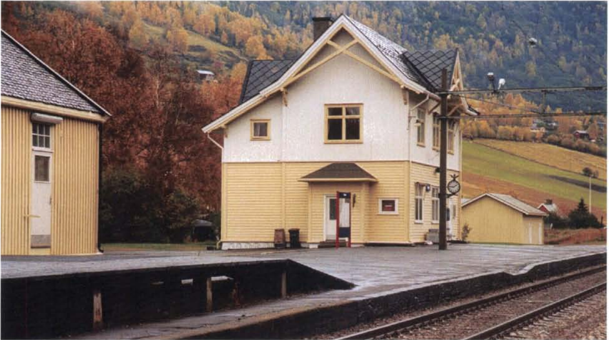
Foto 34: Kvam stasjon i 1998. Stasjonsanlegget fremstår fortsatt som et helstøpt jernbanemiljø med potensiale for videreutvikling/tilbakeføring. Dette arbeidet bør gripes an lokalt. Bl.a. bør kontakten med resten av tettstedet styrkes. Stasjonens bygninger bør få en tyngre farge neste gang et malingstrøk er påkrevet.
