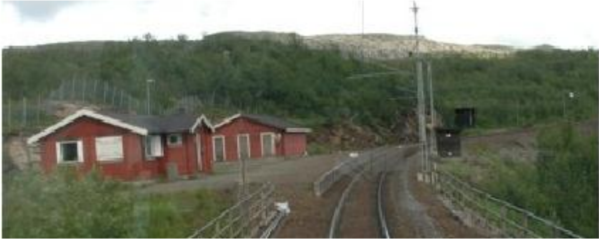
Figur 8: Sjøsterbekk (Bilde: Jernbaneverket.no)
