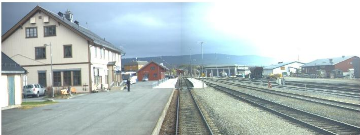
Figur 2: Røros stasjon (Bilde fra jernbaneverkets målevogn)
