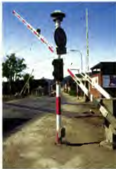
Veisikringsanlegg – mot veien
