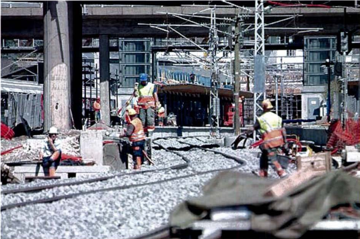
Bilde 1. Anleggsarbeider ved Asker stasjon i forbindelse med bygging av nytt dobbeltspor mellom Skøyen og Asker.
