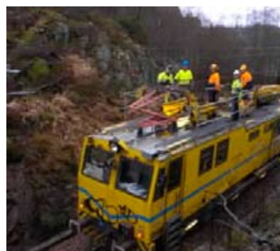
Et nytt kontaktledningsanlegg til 90 millioner kroner mellom Kristiansand og Marnardal på Sørlandsbanen skal erstatte et 60 år gammelt anlegg. Bilde av ledningsvogn. Foto: Øystein Grue
