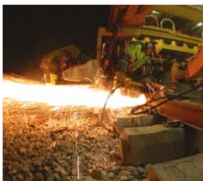
Skinnekapping under sporlegging på Askerbanen (i Skaugum-tunellen). Foto: Øystein Grue.
