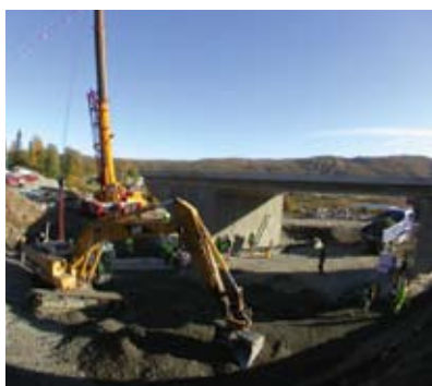
Samtlige bilder fra arbeidshelg på Bergensbanen i september 2005. Ny undergang kommer på plass. Foto: Øystein Grue.
