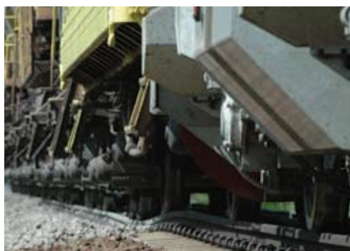
Ballastrens Kongsvingerbanen. Foto: Øystein Grue.
