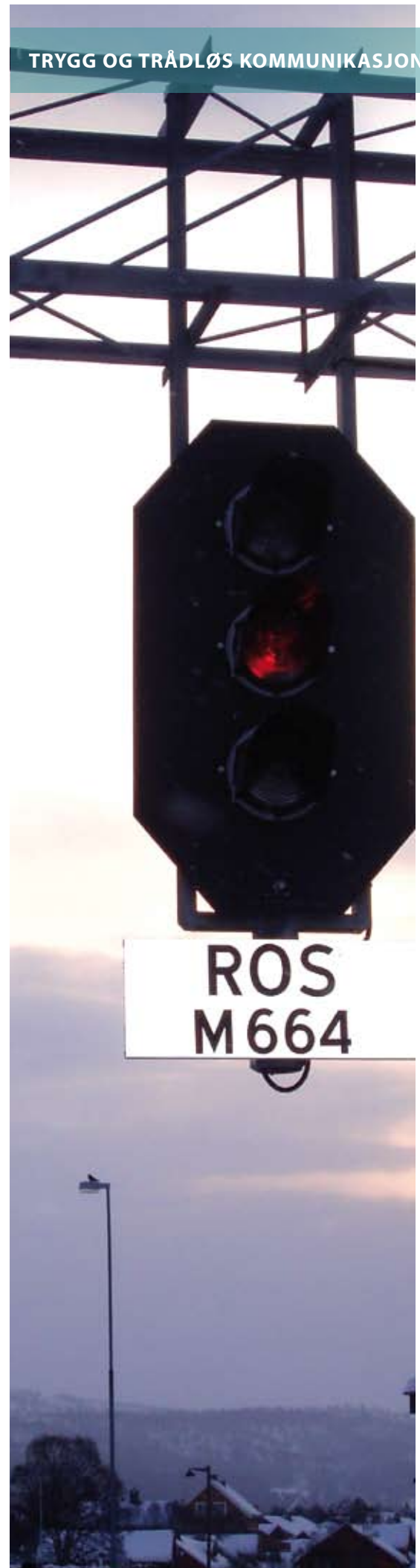
Lyssignal med posisjonsangivelse: 4400 lyssignaler langs jernbanenettet vil bli borte når ERTMS overtar.
