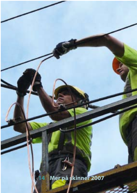
Sørlandsbanen: Oppgradering av kontaktledningen er nødvendig for å forsyne togene med kjørestrøm.
