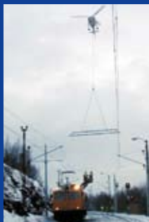
April Jernbaneverket sparer tid og penger ved bruk av helikopter til montasje av kontaktledningsanlegg på Ofotbanen. Foto: Carl Næsje, Fremover
