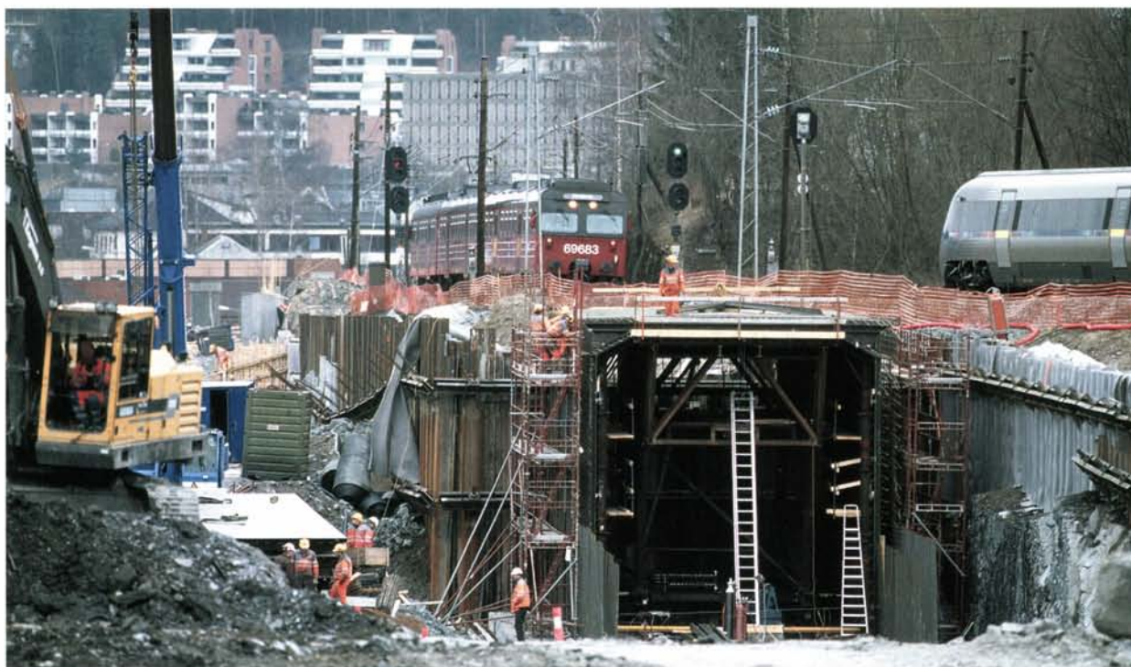
Anleggsarbeid ved Jong (Foto: Rune Fossum)
