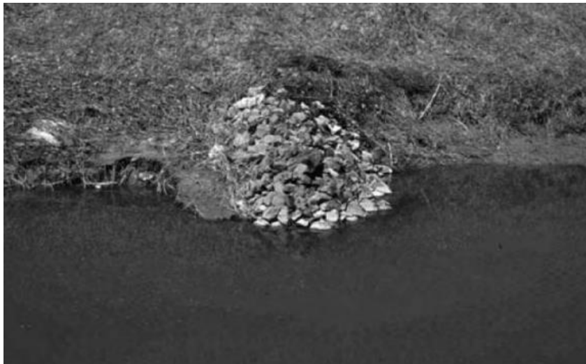
Figur 11: Sikringstiltak, bune. Jensen, L. & Tesaker, E. (2009)
