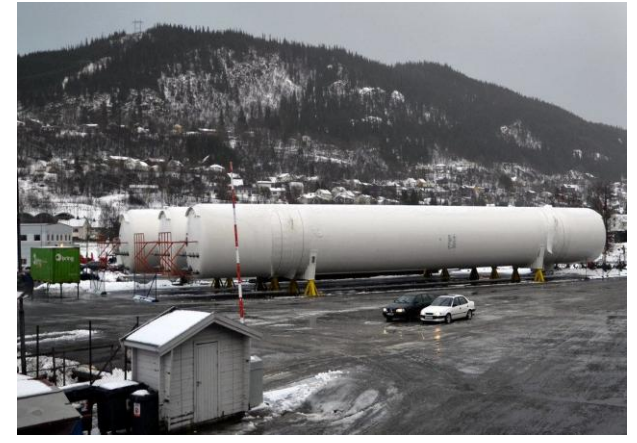
LNG Terminal in Mosjøen
