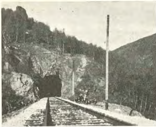
Fig. 10. Søndre indslag. Høgsnyta tunnel.
