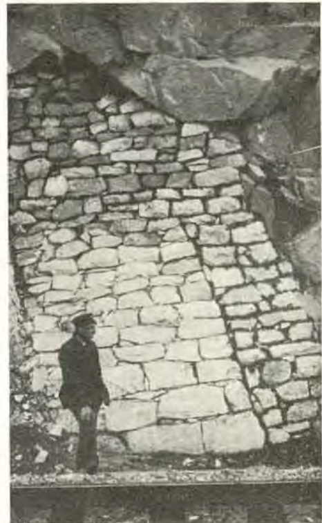
Fig. 18. Drænsnisje i fjeldskjæring.
