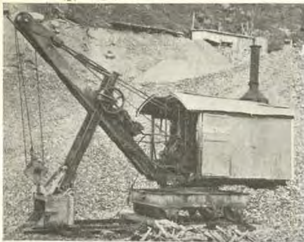
Fig. 8. Gravemaskin i Drivstua pukverk.
