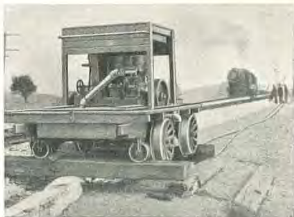
Fig. 28. Svillepakkemaskin.
