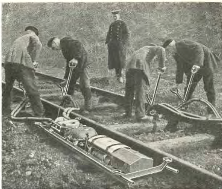
Fig. 29. Svillepakkomaskin i arbeide.
