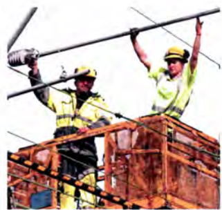
Vedlikehold av kontaktledningen på Kongsvinger stasjon høsten 2011. Foto denne side: Cathrine Riis/ Jernbaneverket.
