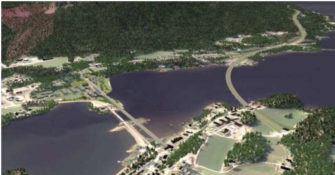
Figur 4.18. Modellutsnitt som viser jernbanestasjon på Sundvollen og vegens linjeføring over Rørvik og Kroksund. Sett nordfra.
