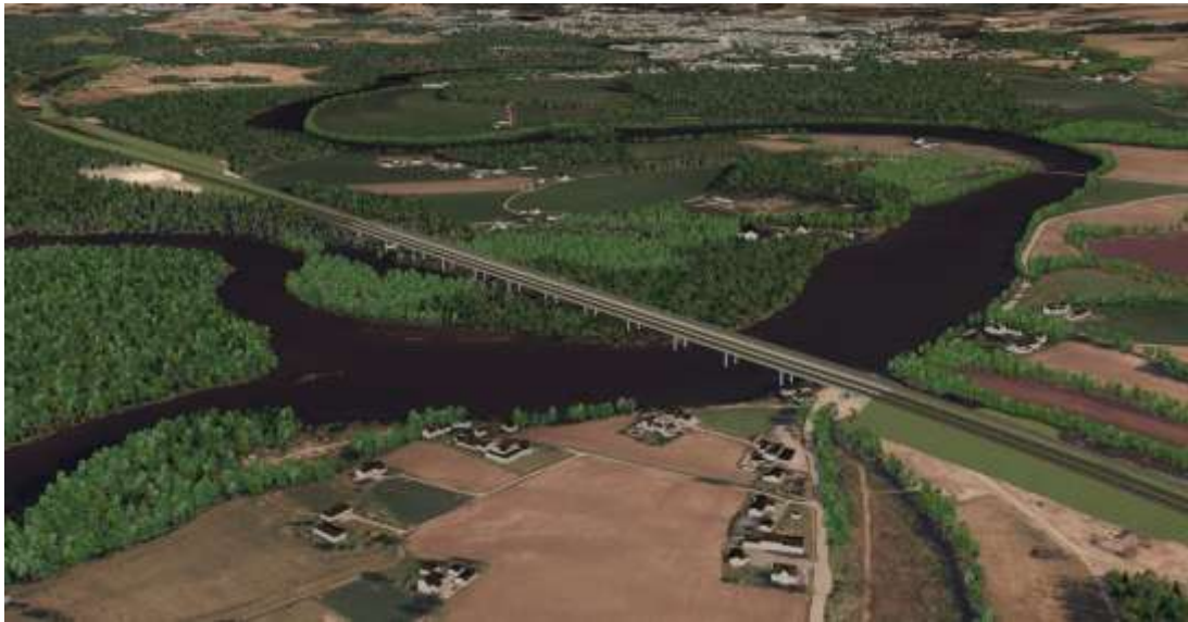
Figur 4.49. Modellutsnitt som viser viadukten over Storelva og Busundområdet. 4bg-bg sett fra sørvest.
