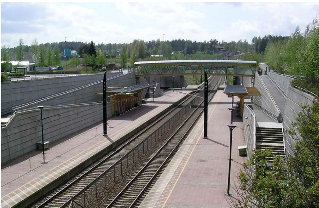
Figur 4.30: Eksempel på nedsenket stasjonsløsning fra Eidsvoll Verk
