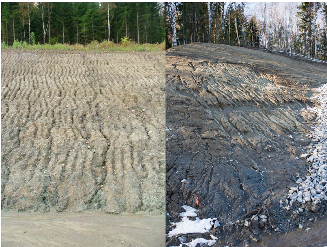
Figur 38. Til venstre et bilde fra HB274,eksempel på overflateerosjon (Foto: Flesjø K., SVV). Til høyre; bilde fra søndre del av stor skråning ved Eidsvoll (Foto: Aavatsmark, E.)
