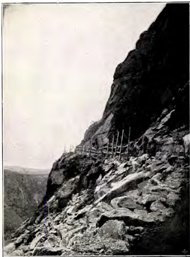
TRANSPORTVEI GJENNEM NORDDALEN.
