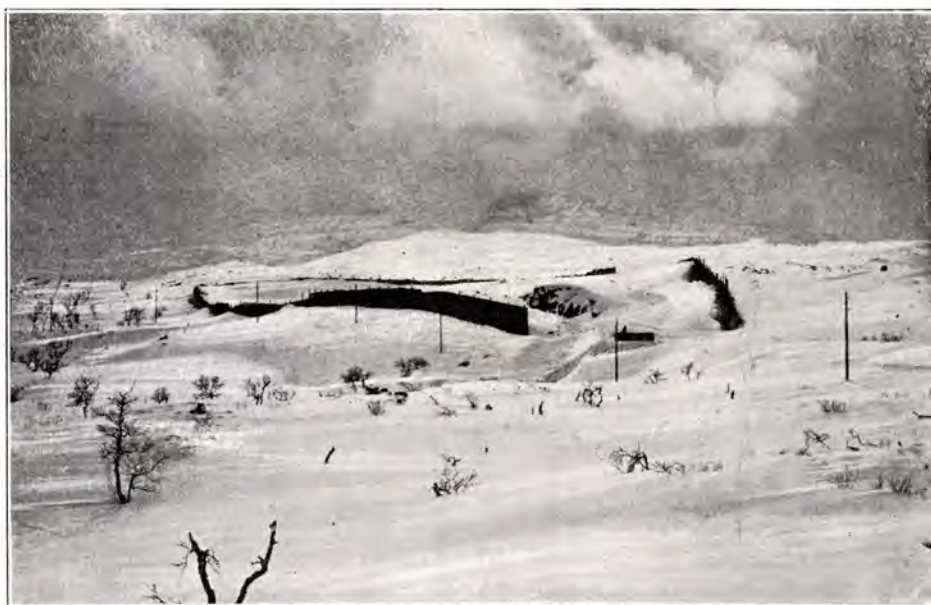
Fot. 3. SNESKJÆRME VED KM. 35.80, APRIL 1903.
