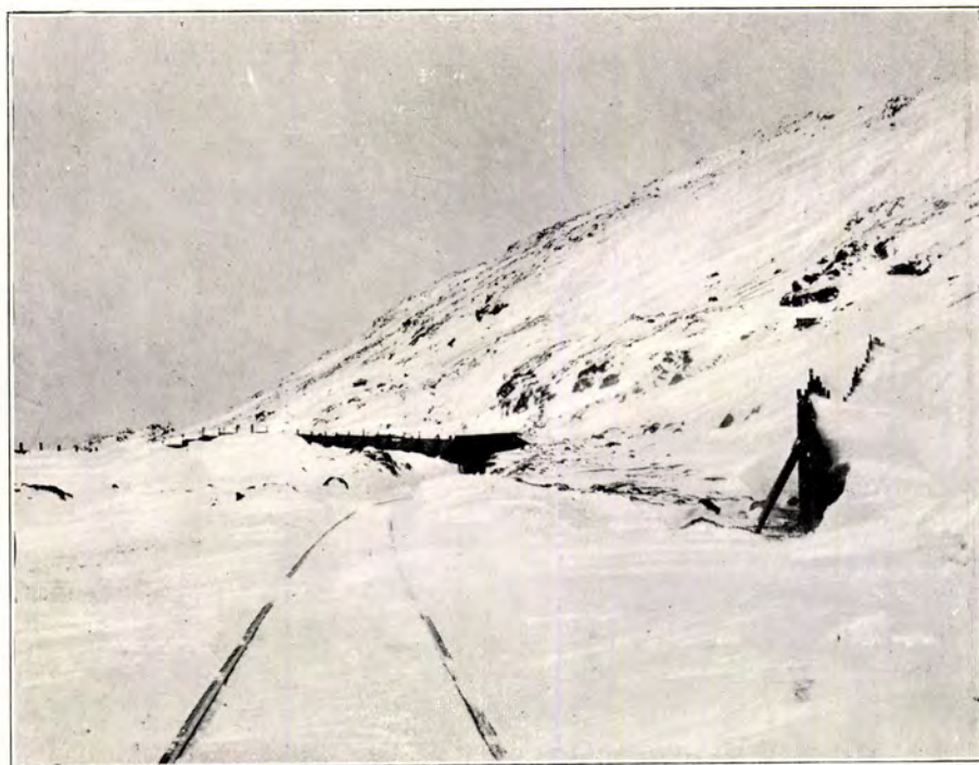
Fot. 8. SKJÆRME OG INDBYGNING KM. 41.10, APRIL 1903.
