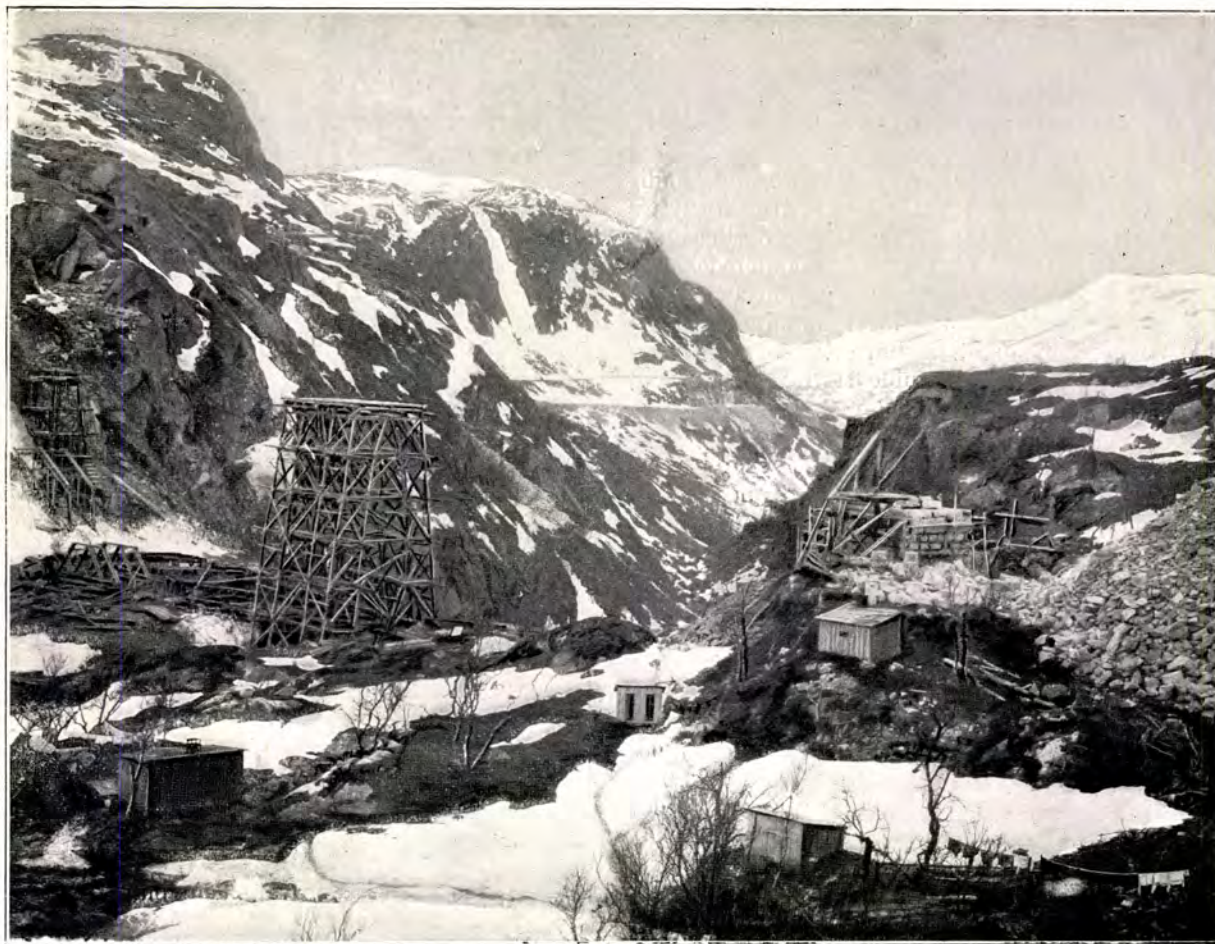
Set fra nordøst mod Hunddalen. 7/6 02. Pillar 1 a færdigklinket. Pillar 1 under sammenbygning. Stilladsspænd 1 a —1 og 1—2 færdig til opheisning.
