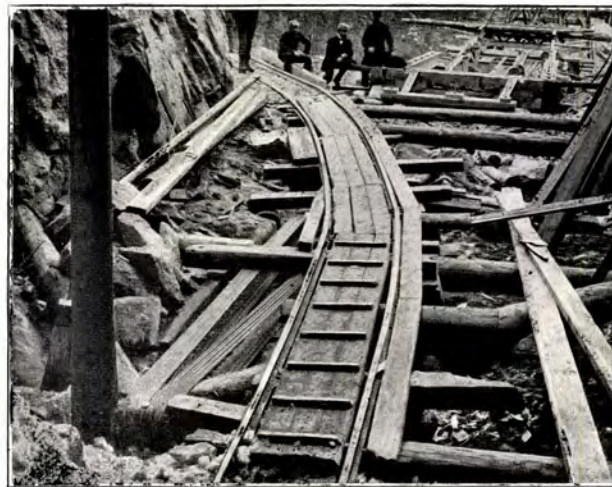
10/6 1902. FORANKRING I TUNNELEN VED SØNDRE LANDKAR.
