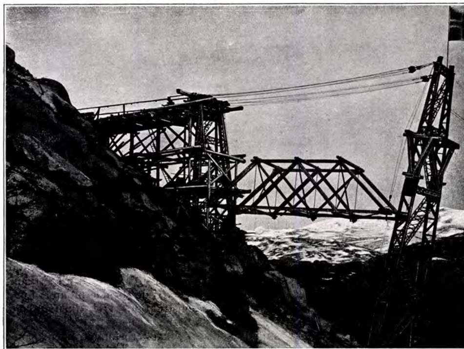
16/6 1902. 18 M.S STILLADSSPÆND UNDER OPHEISNING.
