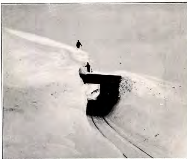
Fot. 7. INDBYGNING KM. 41.10, APRIL 1903.
