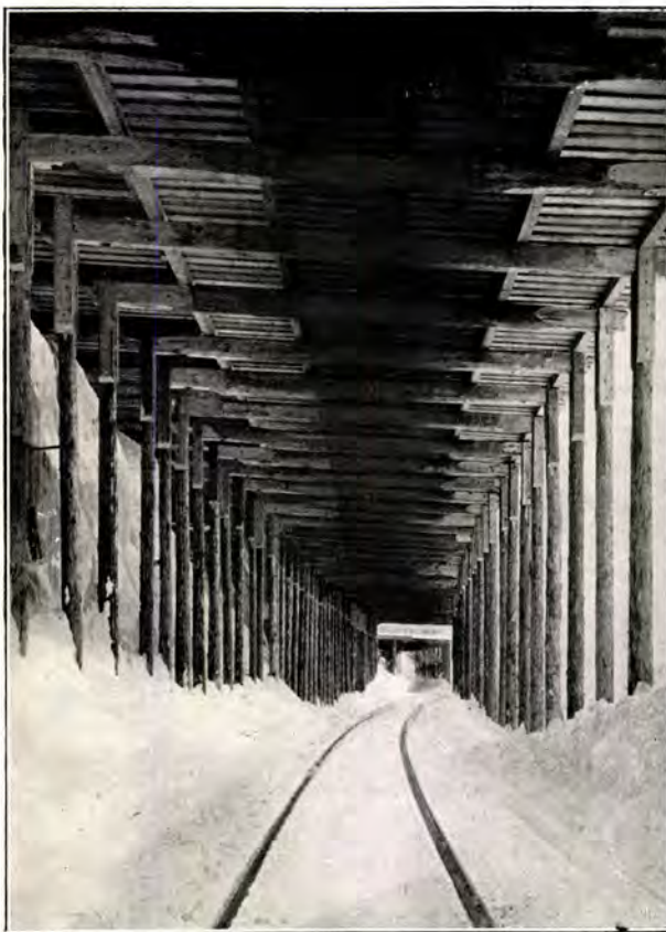
SNEINDBYGNING I NORDDALEN KM. 33.80.
