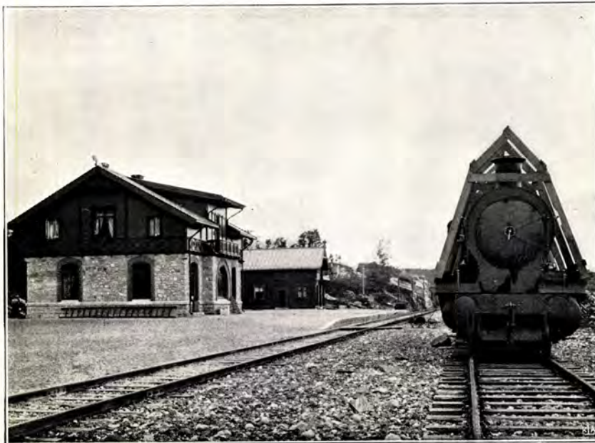
GODSLOKOMOTIV 106 tons tjenestevægt (provisorisk overdækket).
