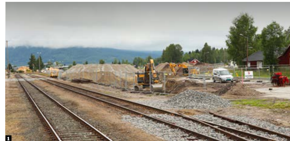
1 KOBLES: Koppang tømmerterminals nye spor kobles på sporet til høyre i bildet.
