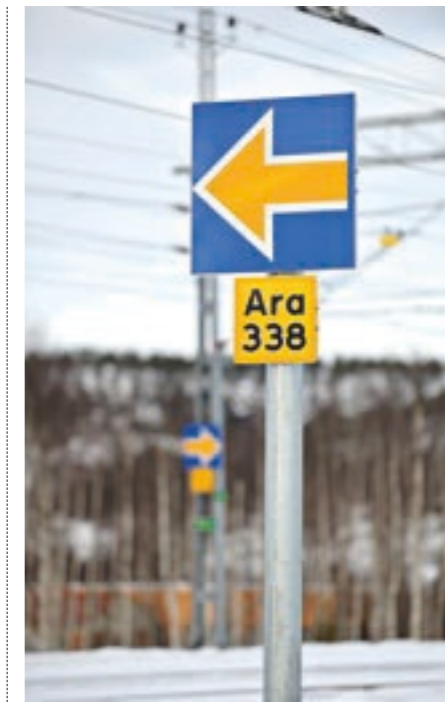
STOPP: Dette skiltet kjennetegner en ERTMS-strekning. Det angir hvor langt fram toget kan gjøre på en holdeplass.
