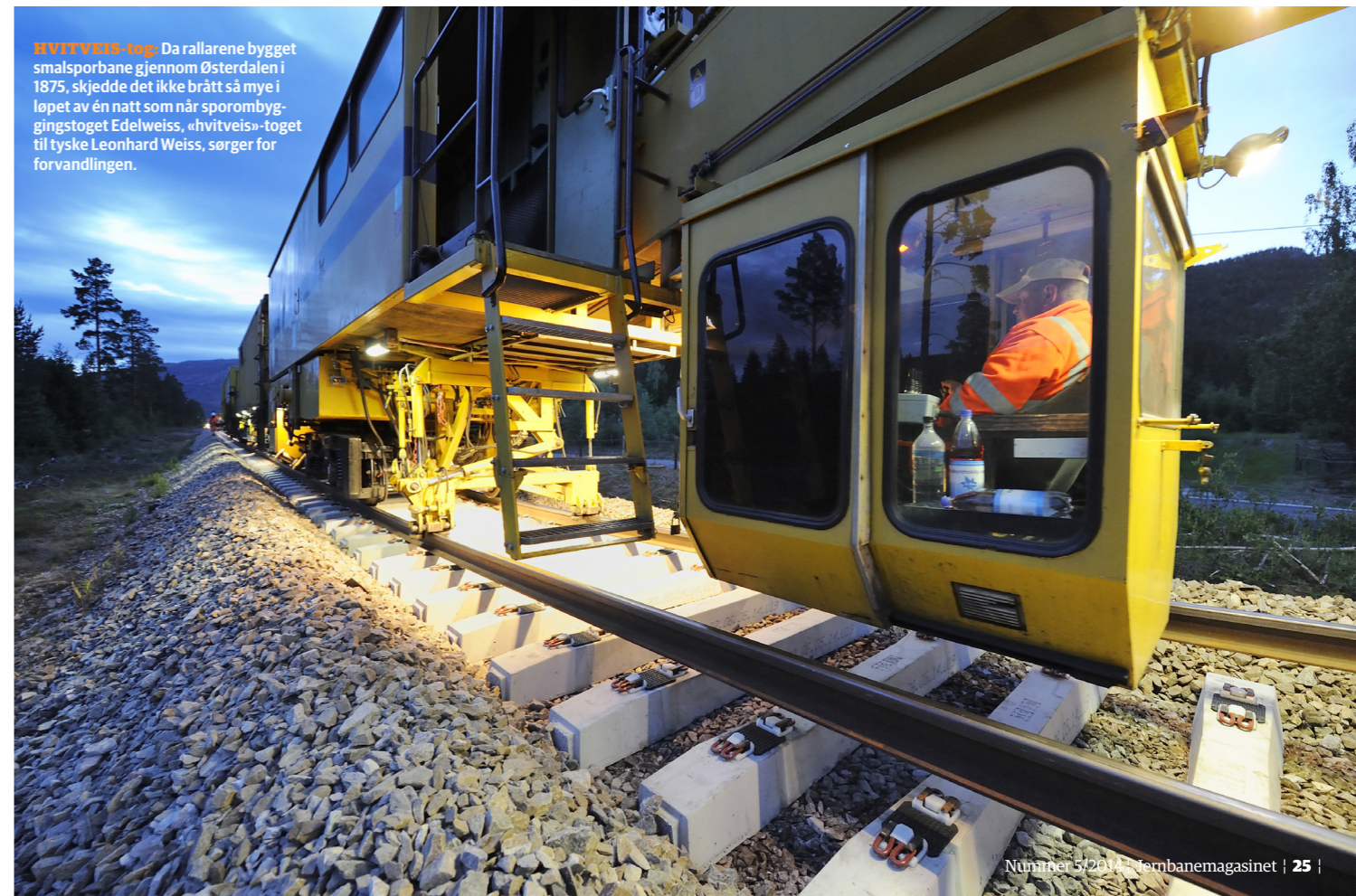
SIGNAL: Signalmontørene Knut Øieroset, Thomas Karlstad og Tarjei Moen fester baliser på nye betongsviller. De er overbevist om at det nå blir færre signalfeil på Rørosbanen.
