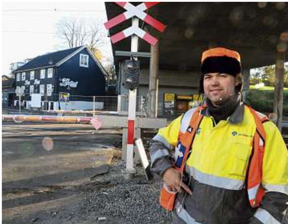
FØRST UT: Planovergangen i nordenden av Moss stasjon får det første datastyrte veisikringsanlegget i Norge. Faglig leder signal, Hans Petter Bredholt, har vært kloss på monteringen av anlegget.
