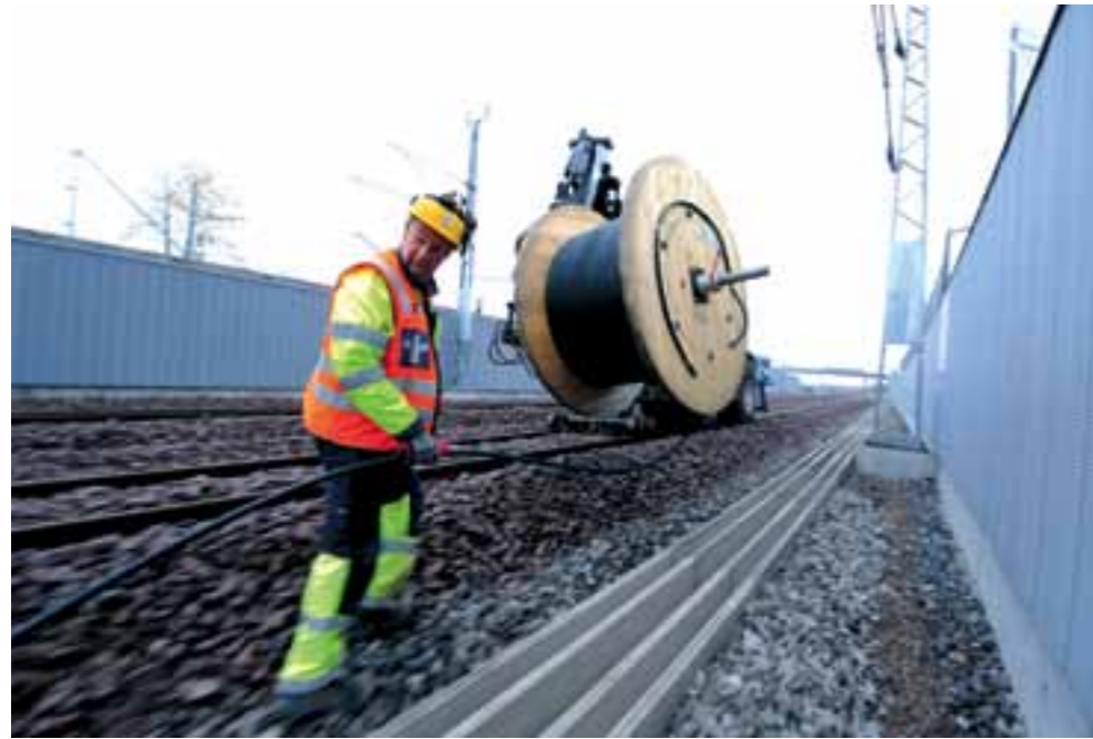
SIGNAL: Jørn Halvor Torsdal, lokal sikkerhetsvakt i Strukton Rail trår til og sørger for at de siste kilometer med signalkabel legges i riktig kabelkanal på Barkåker stasjon.
