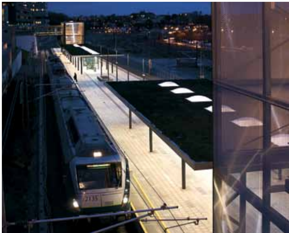
FLOTT UTTRYKK: Stålduken i adkomstbyggene har gitt holdeplassen på Paradis et flott uttrykk. Nå blir den også brukt ved moderniseringen av holdeplassen på Holmlia.
