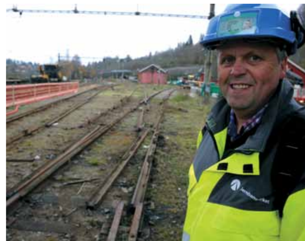
RIVER SPOR: På rekordtid skal Asbjørn Rasdal sørge for at det bygges seks hensettingsspor, to driftsspor og et nytt vendespor tilknyttet Eidsvoll stasjon.
