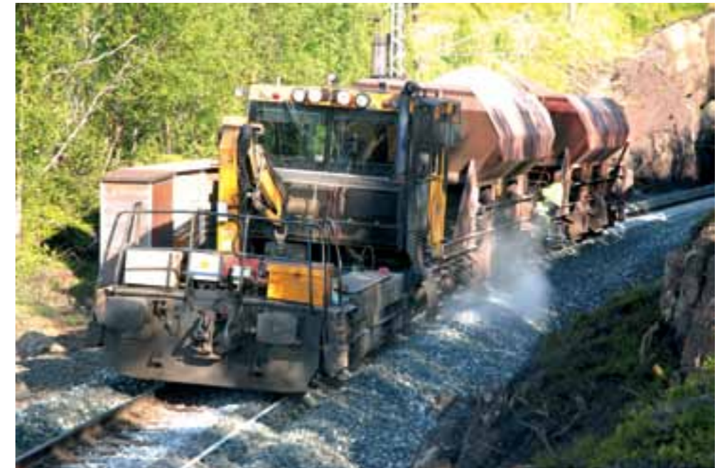
ARBEIDSHEST: Lastetraktorene er arbeidshesten i Jernbaneverket. Her er en type 26 i arbeid med ballastsupplering på Ofotbanen.
