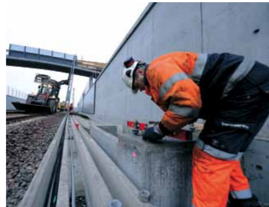
SISTE: Med vater og millimeterpresisjon justeres boltemuttere og skiver før Huddig-traktoren løfter siste KL-mast på plass på Barkåker.
