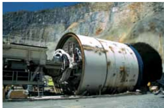
SVÆR MASKIN: 125 meter lange maskiner borer, tetter og monterer ferdige betongelementer.
