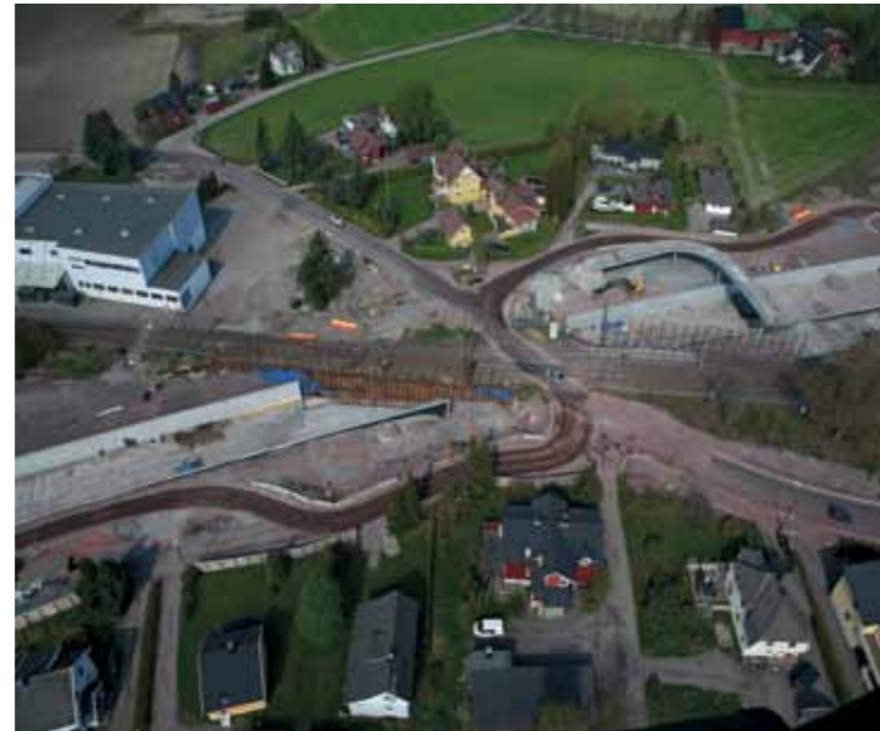
MISSING LINK: Planovergangen på Barkåker skal fjernes og betongtrauet skal bygges ferdig i løpet av noen hektiske høstuger. 7. november skal det første toget gå på nytt dobbeltspor.
