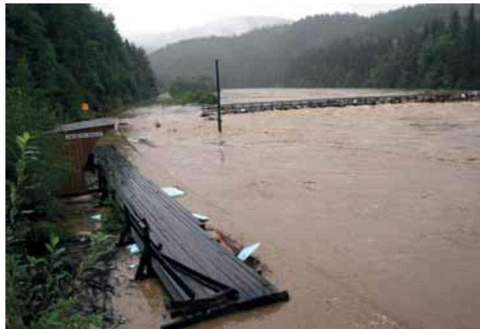
BLØTT: Ved Gildset i Haldalen lå Rørosbanen lenge gjemt under vann fra elven Gaula. Bare her ble det vasket bort mer enn hundre kubikkmeter med pukk.
