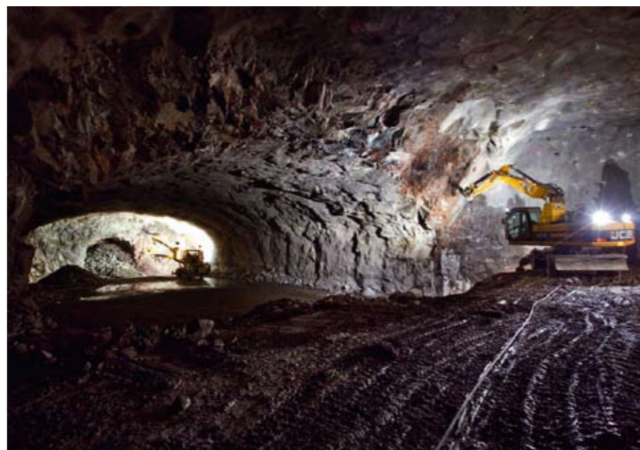
STORANLEGG: Citybanan i Stockholm skal doble kapasiteten inn og ut av Stockholm C. Det kompliserte anlegget til 16,8 milliarder kroner har så langt kostet tre arbeidere livet.
