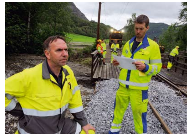
SER PÅ SKADENE: Faglig leder linjen Anders Nicolaysen (t.v.) og geotekniker Alf Kristian Lund fra Norges Geotekniske Institutt besiktiger skadene.
