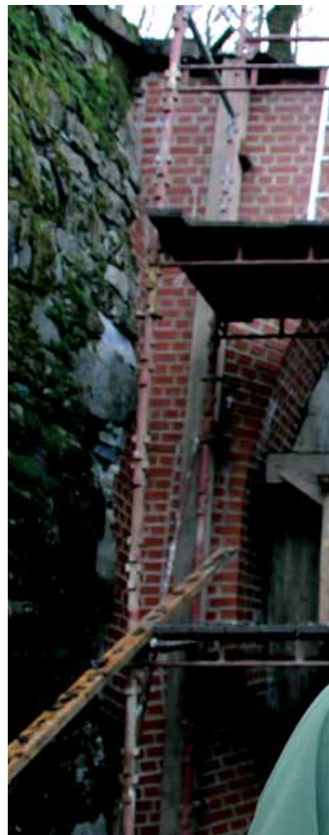
TRE GANGER: Løsmassetunnelen av 1854 var et smertens barn, og den ble nærmest bygd på nytt med større profil i 1884. I år er inngangen nordfra delvis murt opp på nytt.
