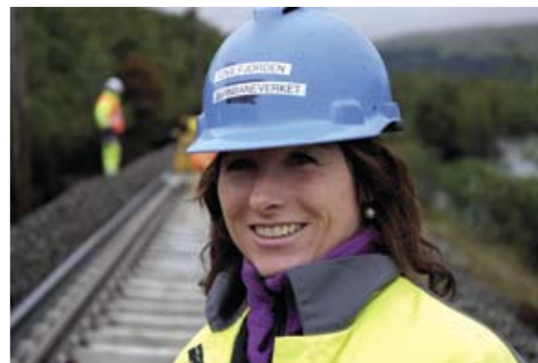
PROSJEKTLEDER: Tove Fjorden leder arbeidet med å totalfornye fjellstrekningen over Dovre for 90 millioner kroner.
