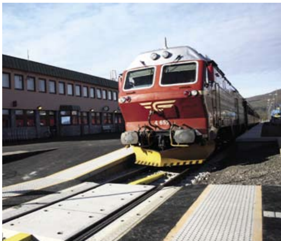
OPPDATERT: Fauske stasjon har fått en grundig runde med fornyelse de siste årene. Til sammen mer enn 60 millioner kroner er brukt på dette.
