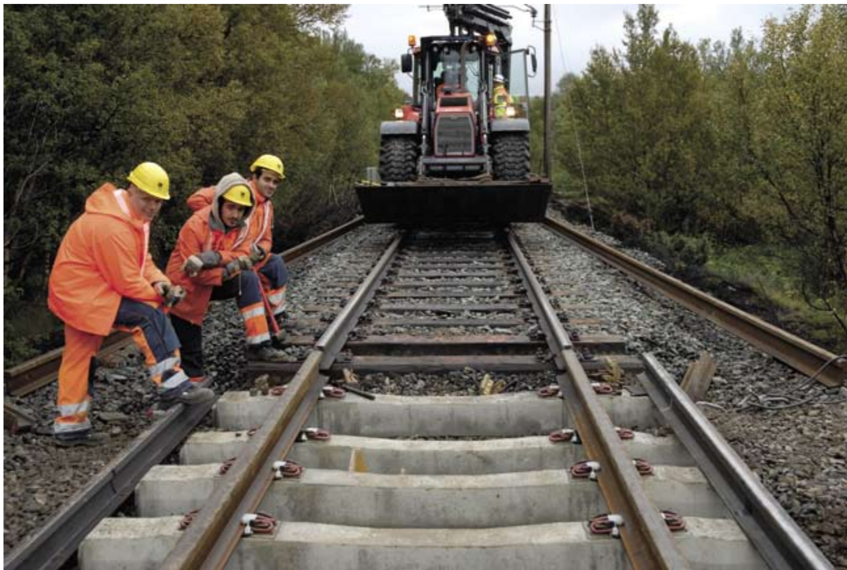
KONTRASTER: Et gammelt og nedslitt spor med tresviller erstattet av et godt og solid spor med betongsviller og kraftigere skinner.
