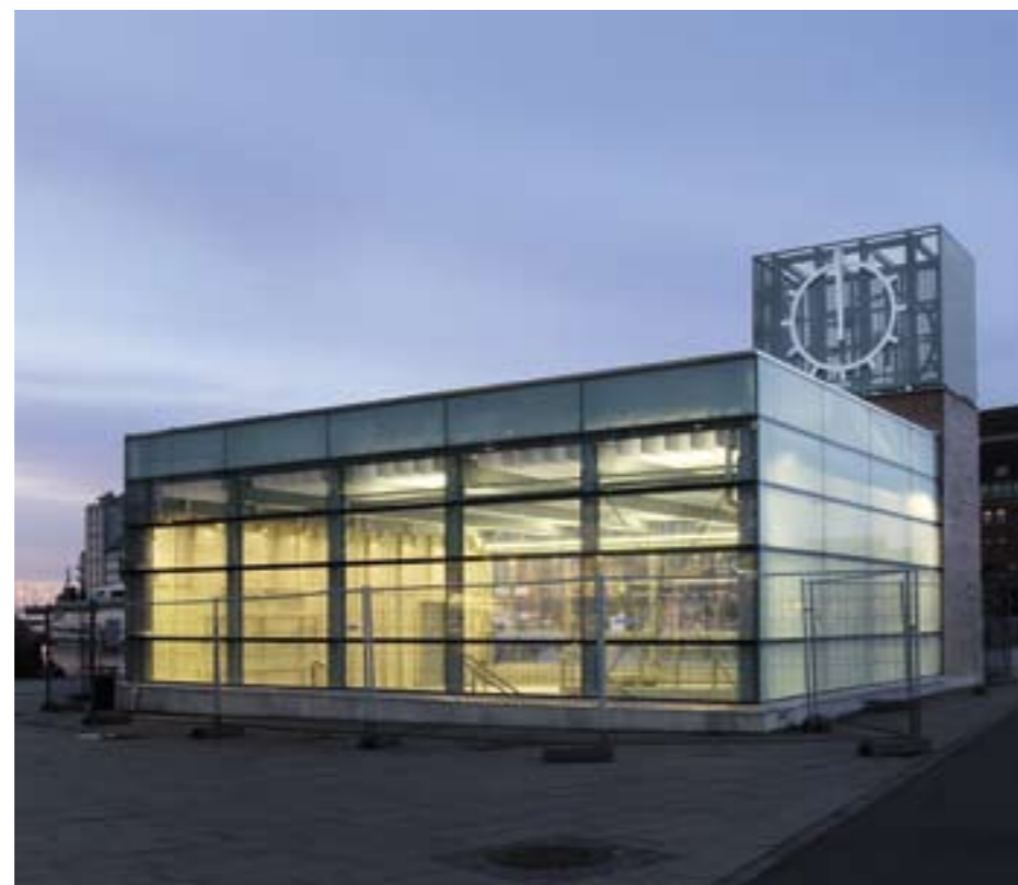
SNART FERDIG: Huset over nedgangen til den nye Malmö C Nedre på Anna Lindhs plass er allerede ferdig. 4. desember blir Citybanen offisielt innviet, men både uka før og uka etter skal det festes for nyanlegget i Skåne.
