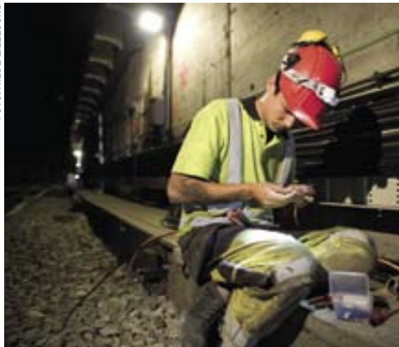
EVIG NATT: Elektriker Jerker Myren hos Strukton skjøter her en elementkabel til sporvekselvarme.
