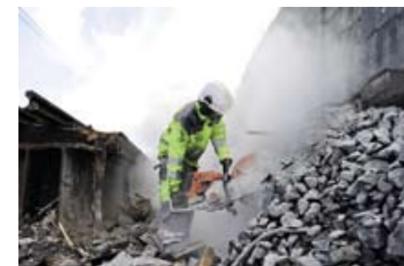
DELES OPP: Før broene kan løftes opp, må de deles opp i fire elementer.
