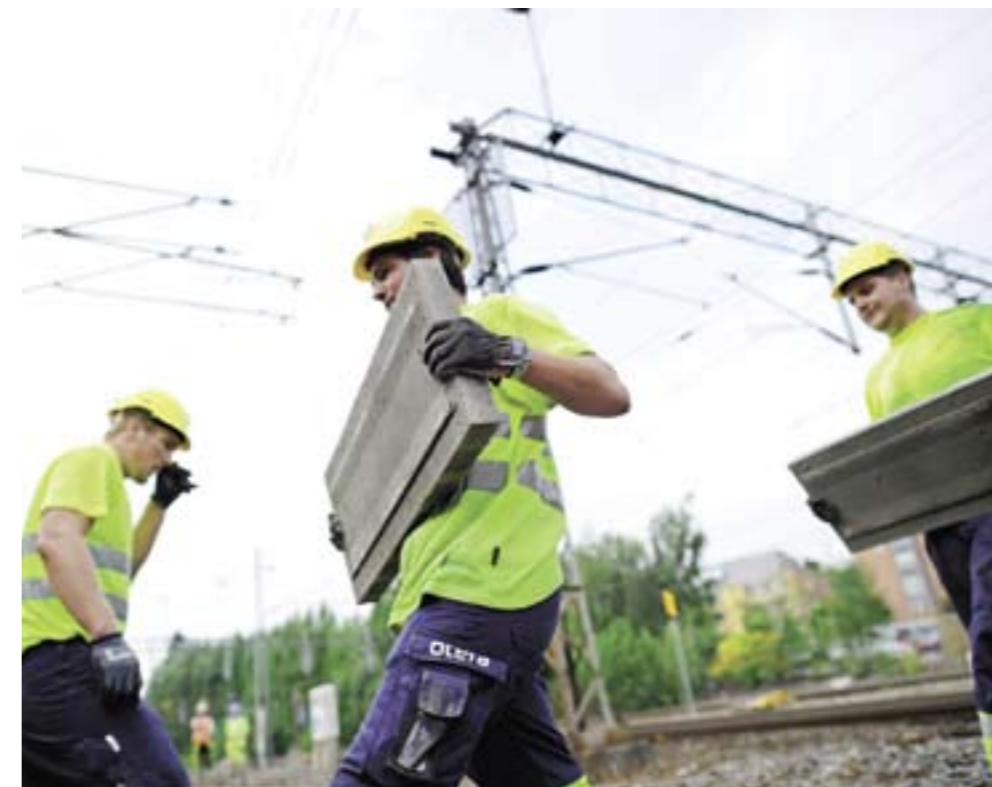
BÆRES: Nye betonglokk som skal dekke over kabelkanalene på Skøyen, bæres på plass.
