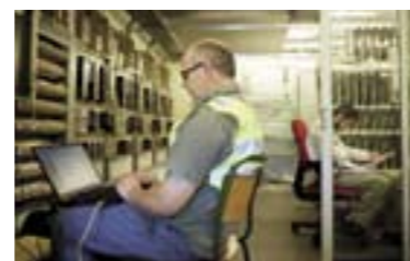
KONSENTRASJON: I relérommet ble det arbeidet med å slutføre koblinger og kontrollere samt å teste anlegget både under og over sporene i løpet av den togfrie perioden.
