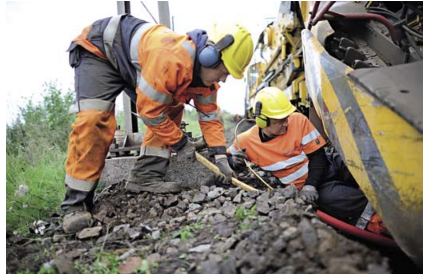
GRAVER FRAM: Det er til tider nødvendig å grave fram steinene som renseverket ikke klarer å få opp.
