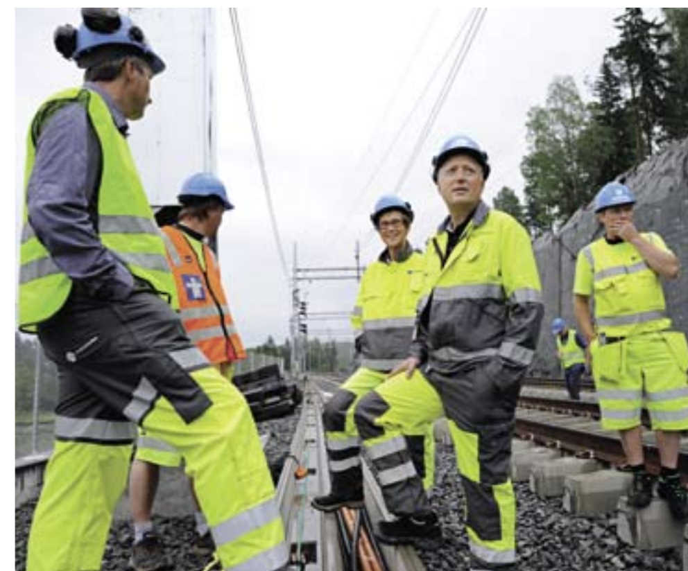
BEFARING: Jernbanedirektøren var på befaring på anleggsområdet ved Sandvika Øst. Fra venstre utbyggingsjef Erik Nilssen, leder for totalbruddet Bjørnar Karlsen, jernbanedirektør Elisabeth Enger, utbyggingsdirektør Harald Nikolaisen og byggeleder Tor A. Trælnes.
