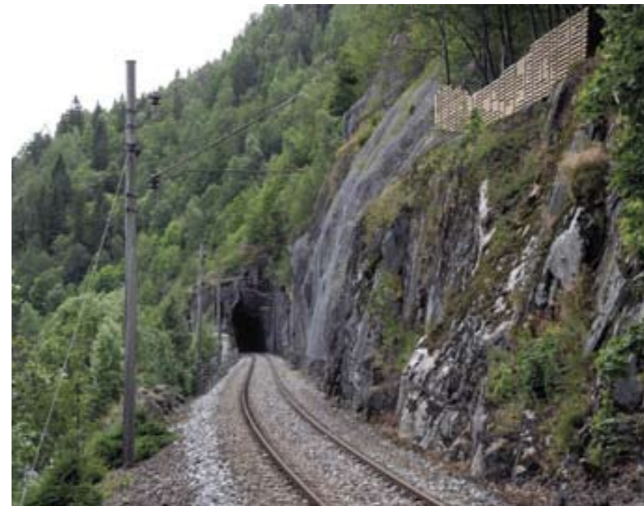
SIKKERT: I sommer ble fire rasutsatte partier langs Farrisvannet sikret med bolter, isnett og fanggjerd. Nå kan togene igjen holde normal hastighet.
