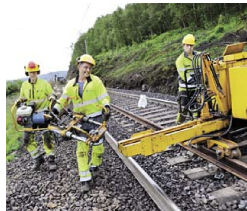
BYTTER SKINNE: Ofofbanen har tøyd grensen for sporkonstruksjonen ved å ha gått over fra 25 tons til 30 tons aksellast. Her er Pål Rogmo, Geir Gjerstad og Torkel Dalan i full gang med å bytte ut en ødelagt skinne.
