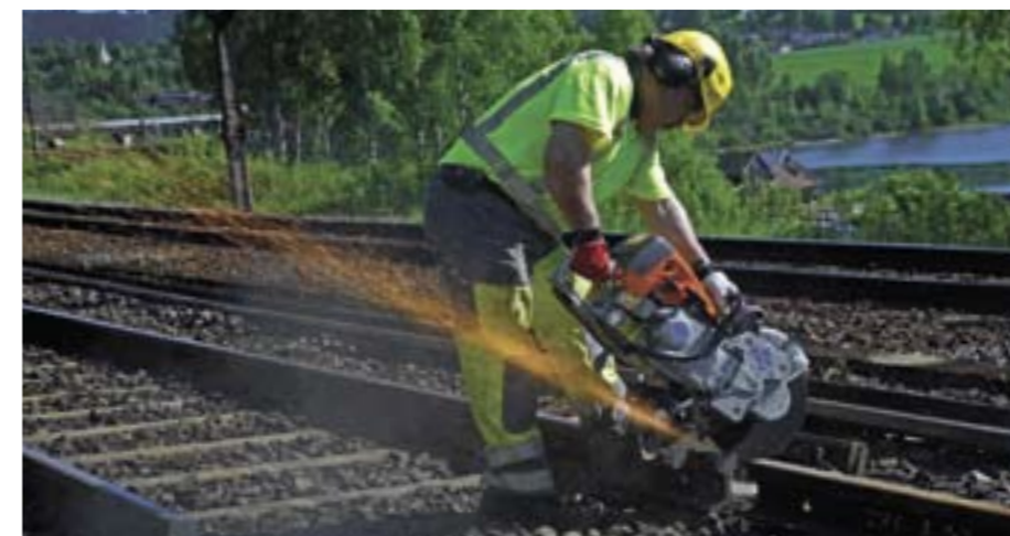
KAPPER: Stein Øybakken kapper og tilpasser nye skinner.
