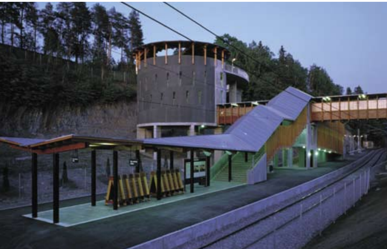
SPESIELL: Arkitekten synes det var moro å jobbe med de store nivåforskjellene mellom spor og terreng på Slependen stasjon. FOTO: JIRI HARVAN
