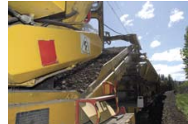
BORT: Forurenset masse transporteres vekk.
