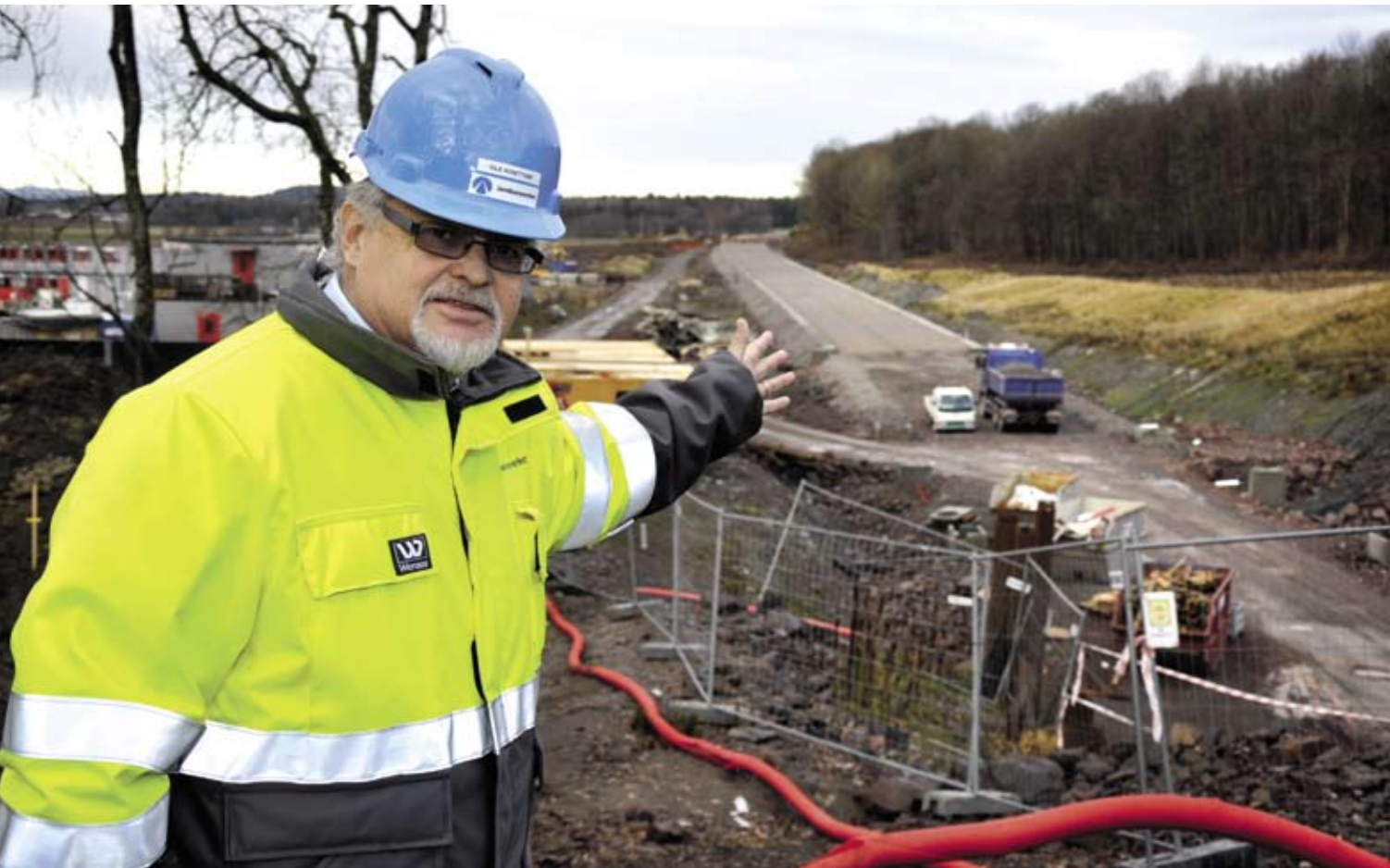
PÅ ÆRVERDIG GRUNN: Utbyggingssjef Ole Kontorp viser fram traseen for det nye dobbeltsporet mellom Barkåker og Tønsberg - med utsikt nordover greveskapsjordene til den gamle greven av Jarlsberg hovedgård.
