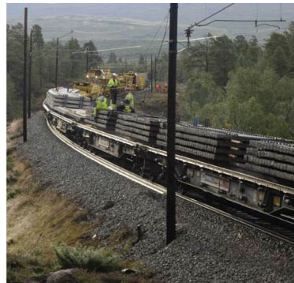
SAKTE: Sporombyggingstoget jobber seg sakte framover i utkanten av Dovrefjell.
