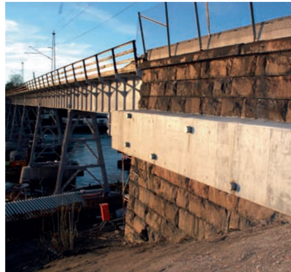
GODKJENT: Rolvsøysund bru fra 1879 var i ferd med å bli erstattet av ei helt ny bru, men er nå rehabilitert.
