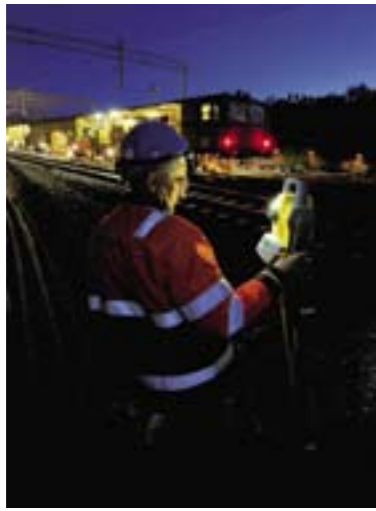
PREISJON: Oppmålingsingeniør Roar Eibakk i Baneservice AS kontrollerer høyde og beliggenhet på sporet.
