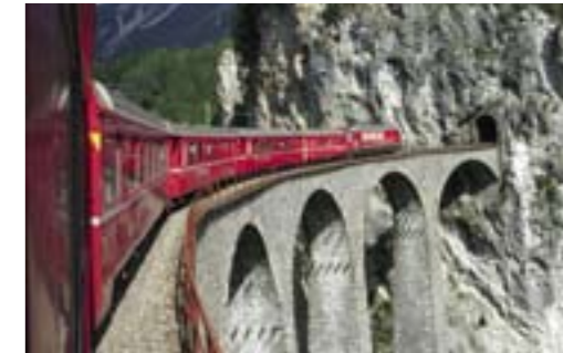
BYGGKUNST: Her passerer toget Landwasserviadukten som er 65 meter høy og 135 meter lang. FOTO: NJÅL SVINGHEIM
