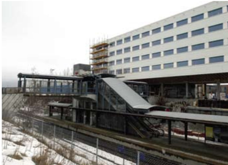
INTEGRERES: I framtida skal flypassasjerene kunne ta rulletrappa fra holdeplassen på Værnes og rett inn i terminalbygget. Bygget til høyre er det nye hotellet som bygges for Radisson SAS.
