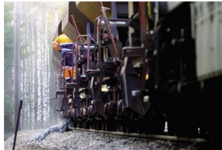
NY BALLAST: Renseverkkjøringa med påfyll av ny ballast på Kongsvingerbanen er utført av Baneservice.
