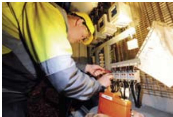
MESTER: Marius er en mester med multimeteret og måler spenning og motstand på relébaserte signalanlegg.
