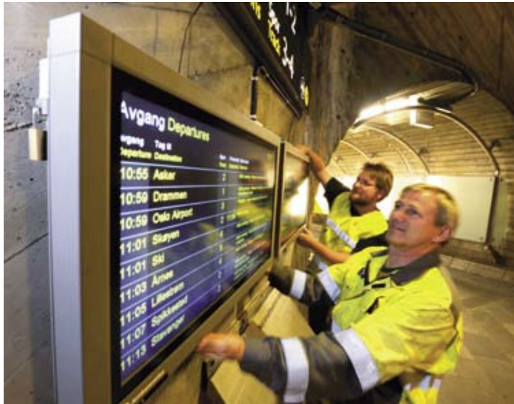
I FULLT ARBEID: Eletroteknikerne Pål Røkbo (nærmest) og Øyvind Bråthen monterer monitor på Nationaltheatret stasjon.
