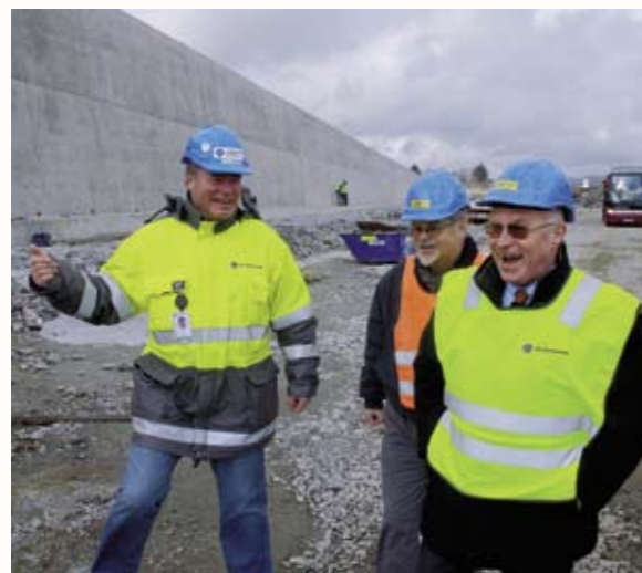
GLEDELIG: Da ny godsterminal på Ganddal ved Stavanger ble bygd.
