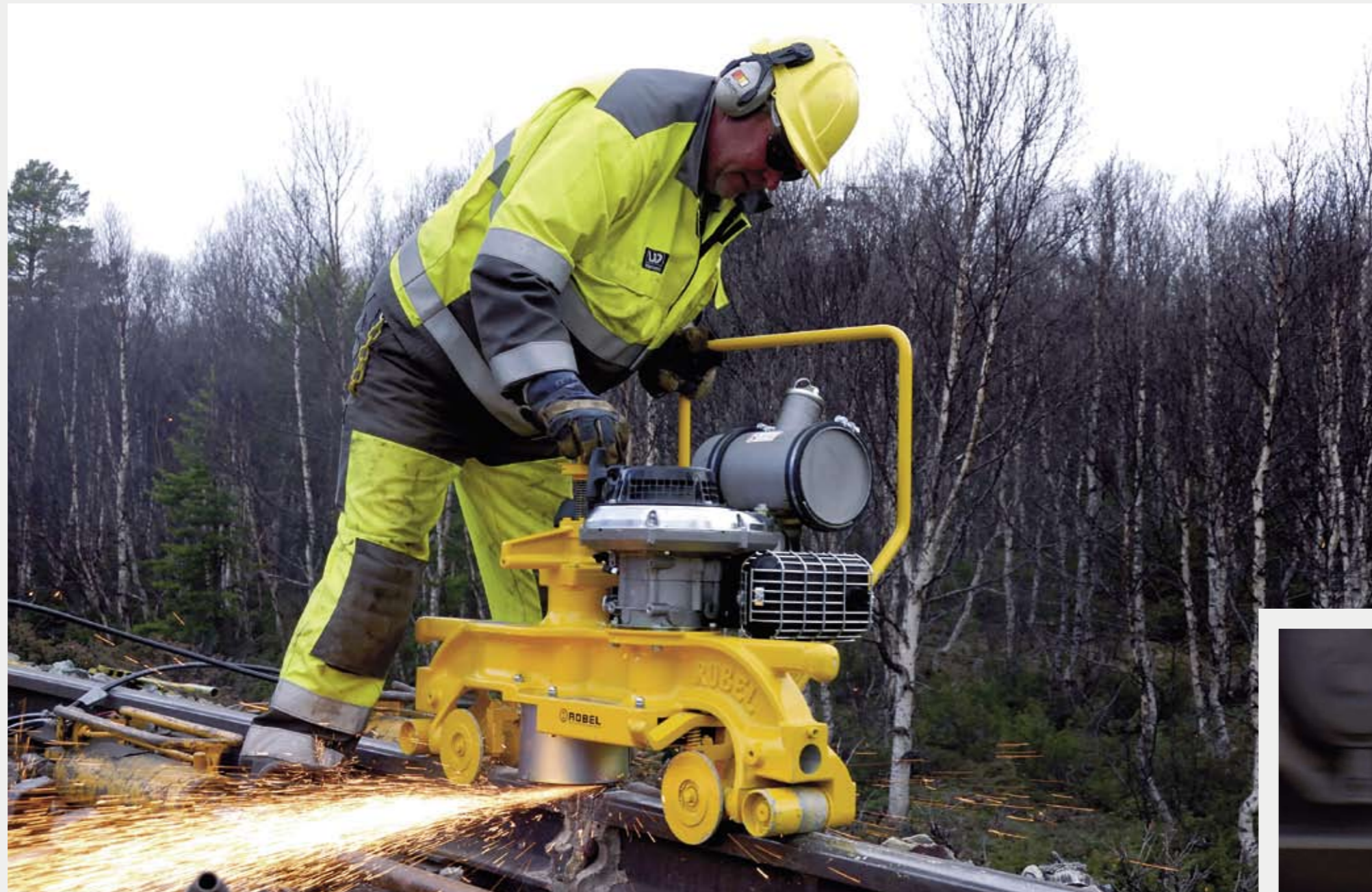
FINSLIPING: Terje Hell sliper sveisen tvillingbroen har laga.
