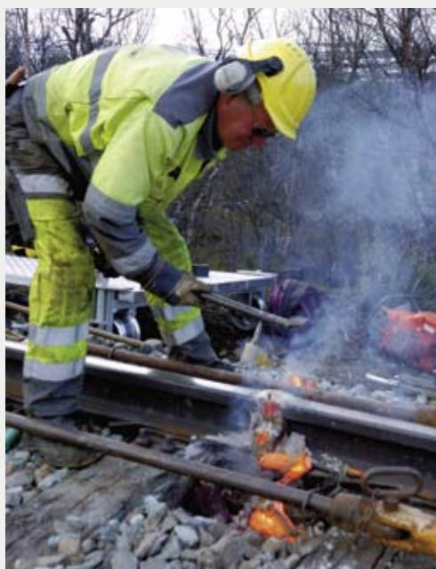
SLAGG: Roar Hell fjernar det som er til overs etter sveisinga
