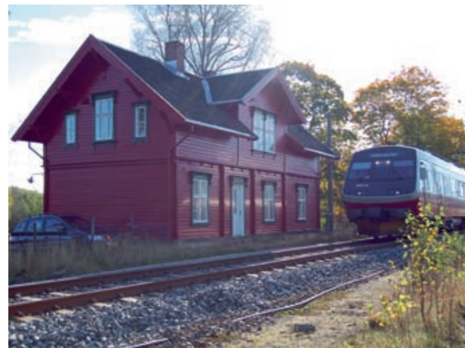
NY STOPP: Den 19. november starter byggearbeidene på en helt ny plattform, og på nyåret skal toget stoppe på Torp holdeplass.
