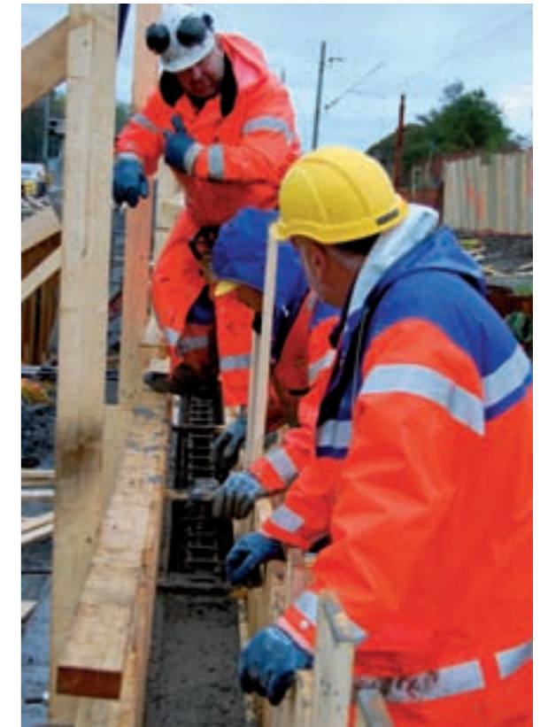
FORSKALING: Ved den nye holdeplassen på Gausel ble tonnevis med betong brukt under togfri helg. Forskalingsnekkere fra venstre: Willy Tjelle fra Sola betong, Errold Haugen og Steinar Furali begge fra Veidekke.
