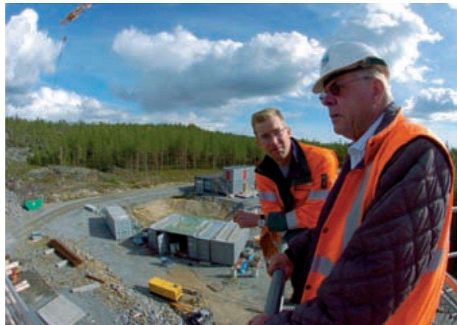
ANLEGGSEDERE: Byggeleder Stefan Svensson i Botniabanen AB diskuterer med plassjef Robert Söderberg i PEAB under støping av en betongbro sør for Umeå.
