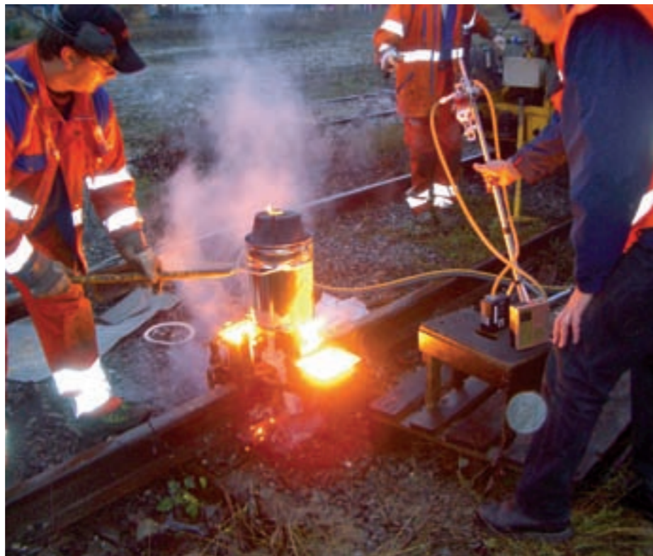
PRIVATISERES? Banverket Produktion i arbeid med termittsveising ved Hallsberg.
