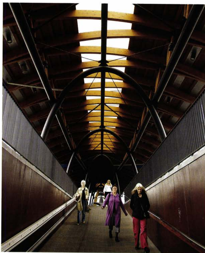
SAMME: Mellomplattformene på Drammen stasjon er allerede bygd om. Nå står hovedplattformen for tur.
