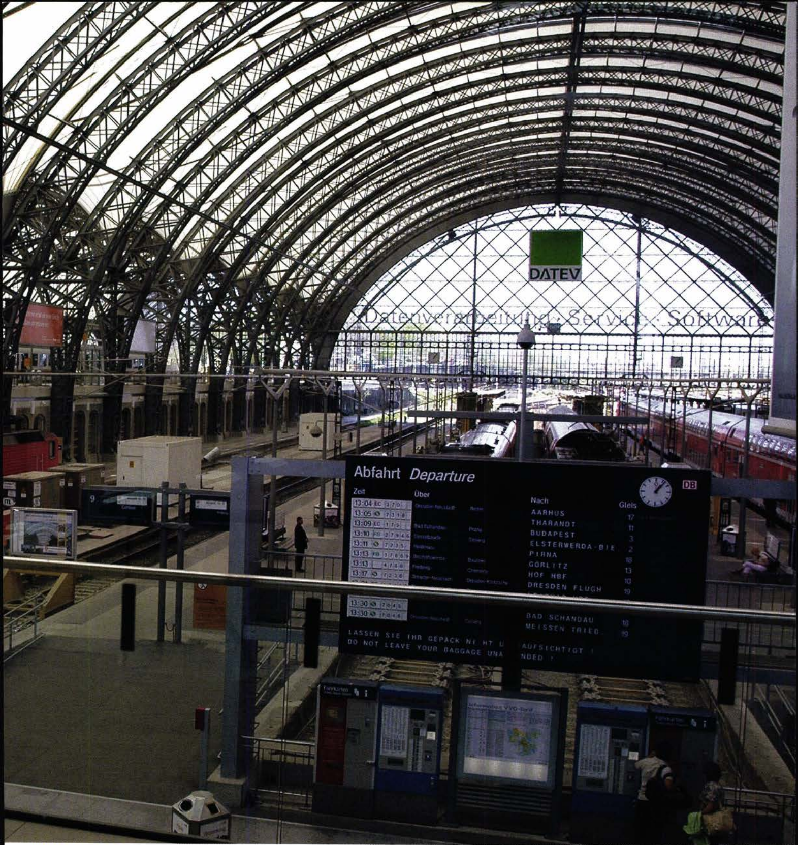
NIVÅFORSKJELL: Her ses tydelig nivåforskjellen mellom de gjennomgående sporene til venstre og buttsporene i midten.
